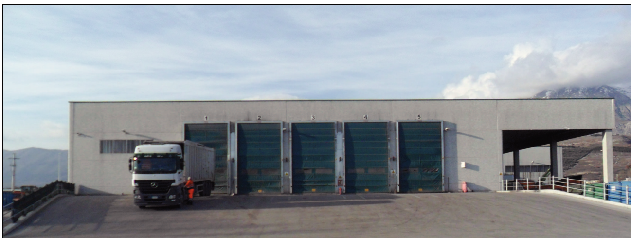
Figura 19: Portoni di ricezione dell'impianto.
