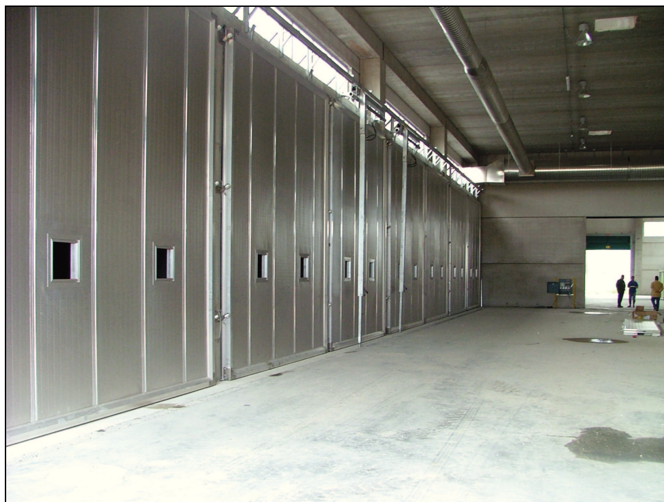
Figura 14: Portoni di chiusura delle biocelle che saranno uguali a quelli già in uso in impianto.
