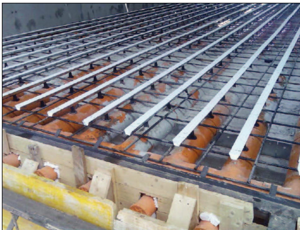
Figura 13: Particolare della messa in opera del pavimento insufflato delle biocelle
