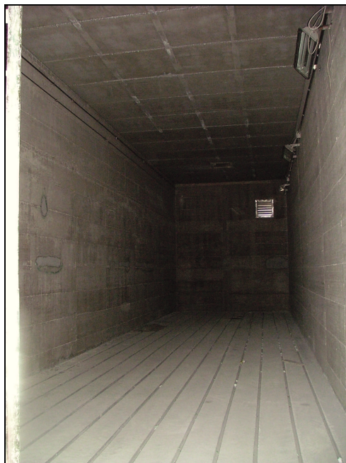
Figura 2116: Interno delle attuali biocelle. Le scanalature a pavimento ospitano i fori per l'insufflazione dell'aria.
