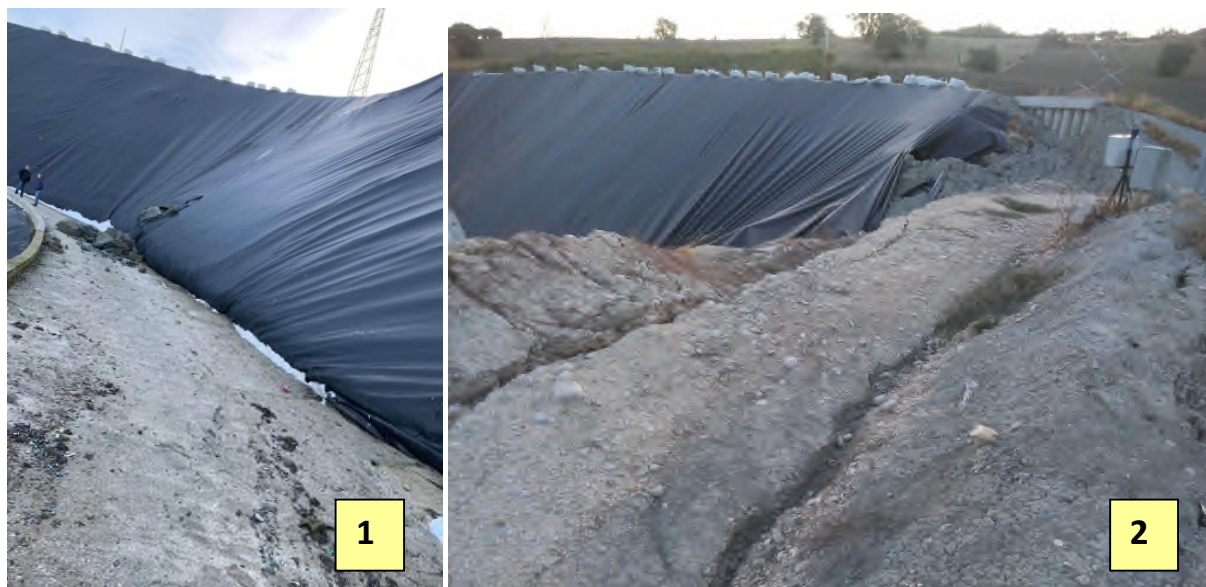
Figura 11 – L’inizio dello smottamento-1 e lo stato della stradina di servizio-2
