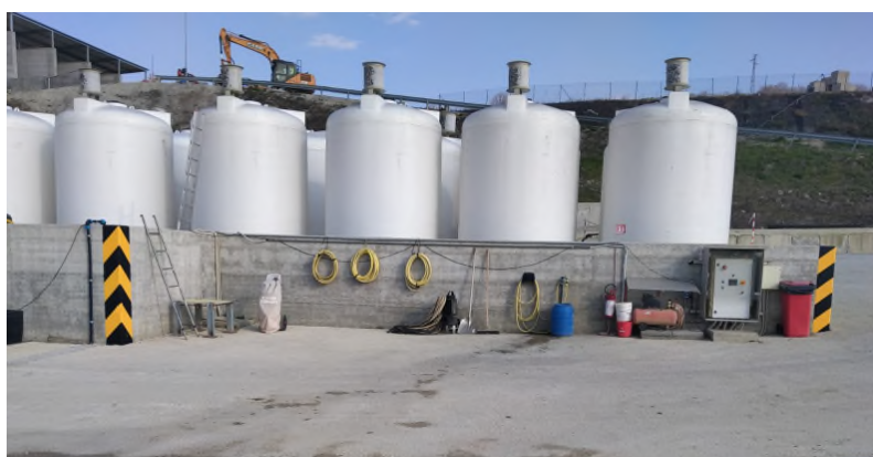
Foto 10 -I serbatoi di stoccaggio del percolato
