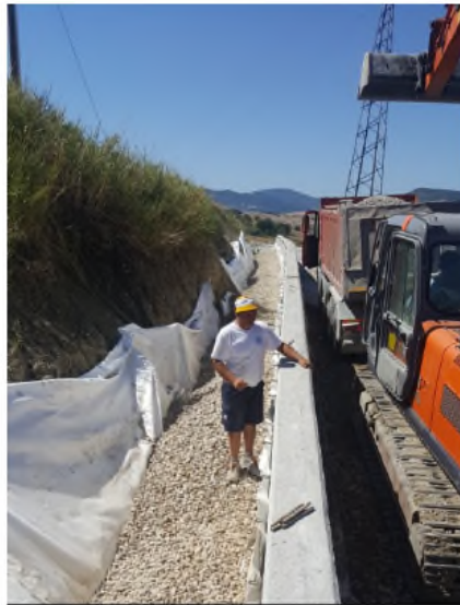
LA REALIZZAZIONE DEL DRENAGGIO DIETRO IL MURO DI RECINZIONE - FOTO 1 e 2
