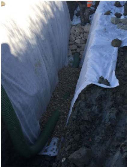
PARTICOLARE DRENAGGIO DIETRO RECINZIONE - FOTO 3 e 4
