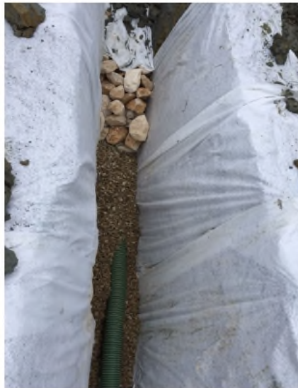
PARTICOLARE DRENAGGIO DIETRO RECINZIONE - FOTO 3 e 4
