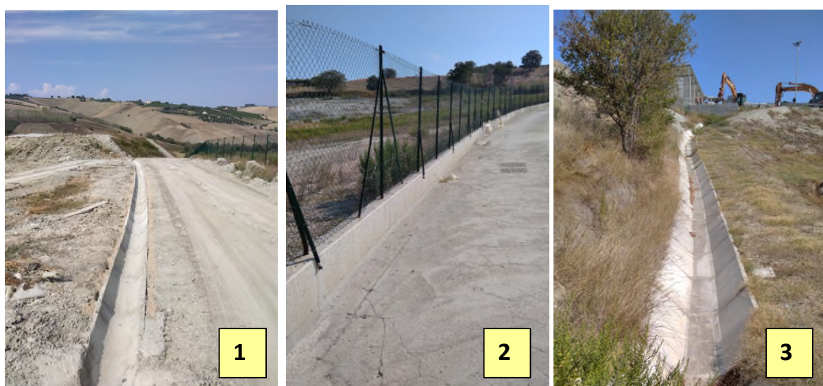
Figura 9 – Tipico canalette a sezione semicircolare-1, alla francese-2 e a sezione trapezio-3
