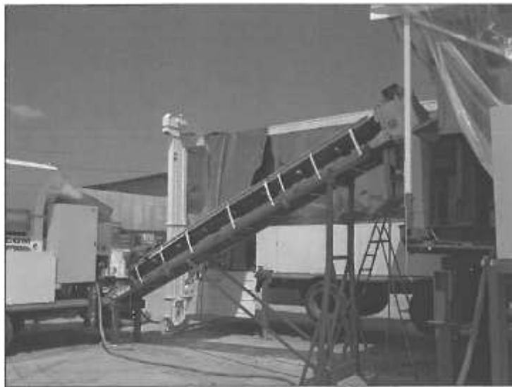
Foto 3. Nastro di alimentazione essiccoio
