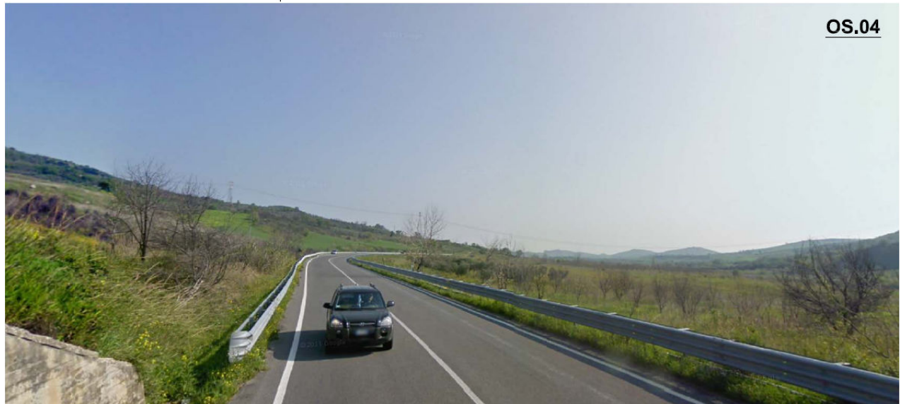
Figura 35 – Vista dell'area di progetto dalla SS 650
