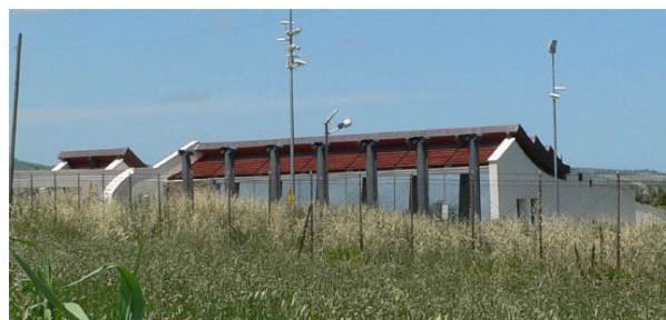
Figura 47 Il punto R2 – servizi annessi al parco fotovoltaico (Cupello)
