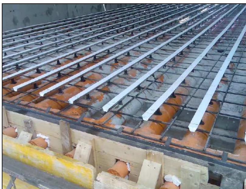
Figura 24: Particolare della messa in opera della platea delle biocelle.
