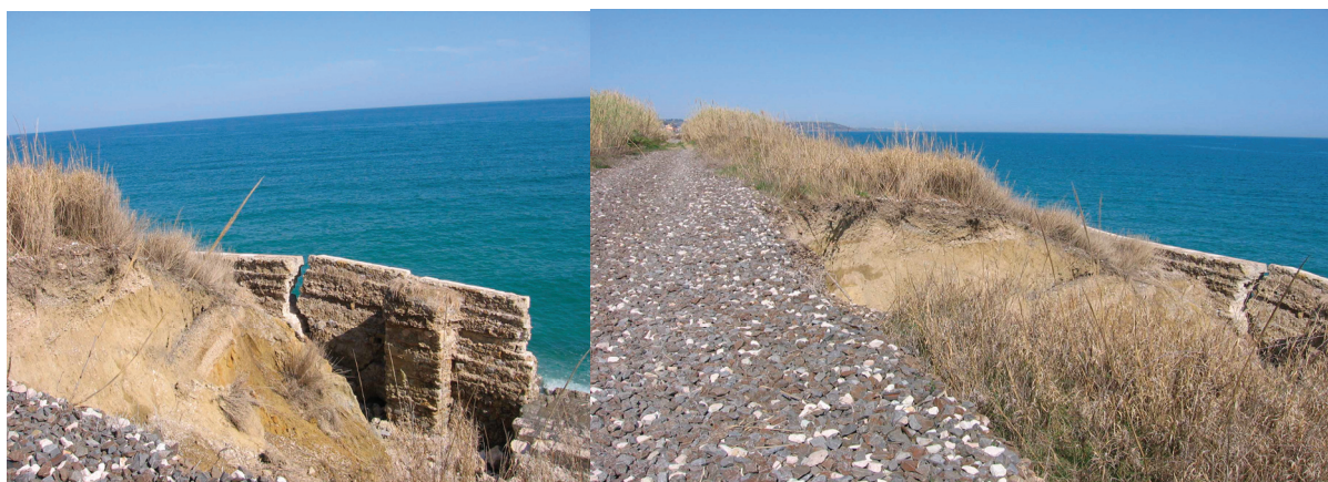
Torino di Sangro:frana e smottamento dell'ex tracciato ferroviario
