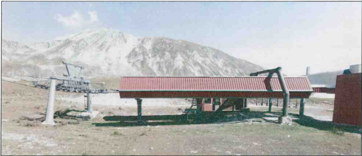
Figura 9: Vista stato attuale della stazione di valle (da google map).
