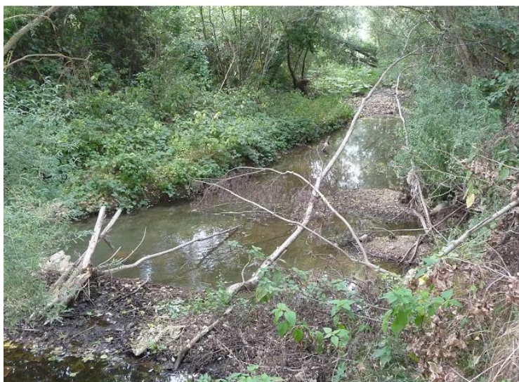
Figura 5.30 – Stato degli alvei nei pressi della confluenza tra Turano e Cammarano.
