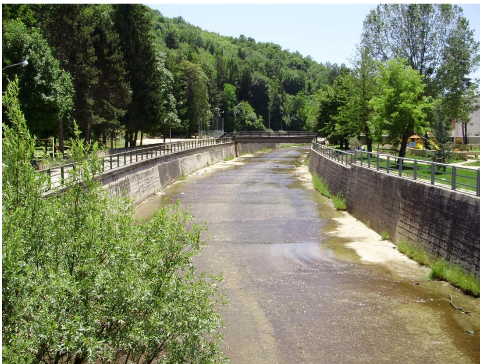
Figura 5.16 - Corso d'acqua Vallemura all'interno dell'abitato di Carsoli.
