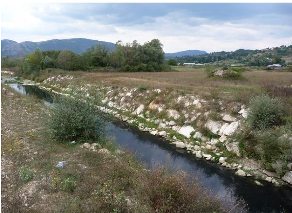
Figura 5.18 - Area golenale destra, a valle della Zona Industriale.
