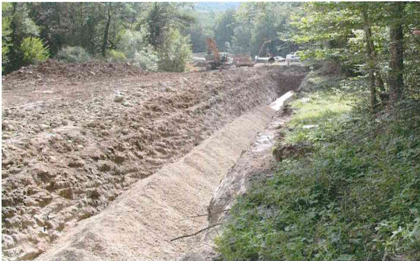
Foto tipica di rinterro della condotta
