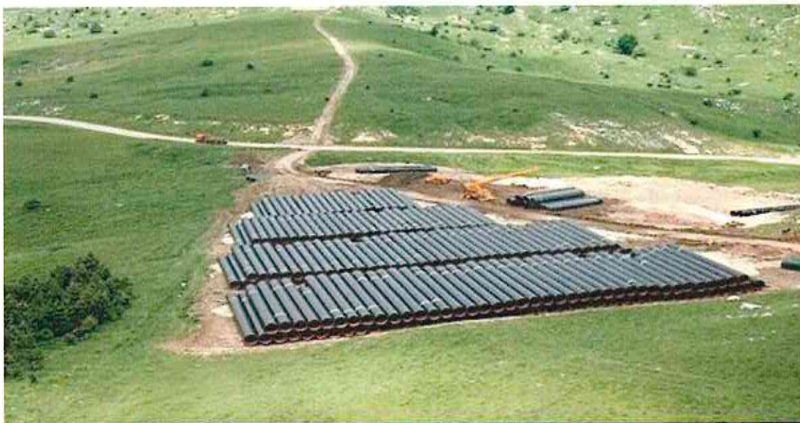
Foto tipica di una piazzola per accatastamento tubazioni
