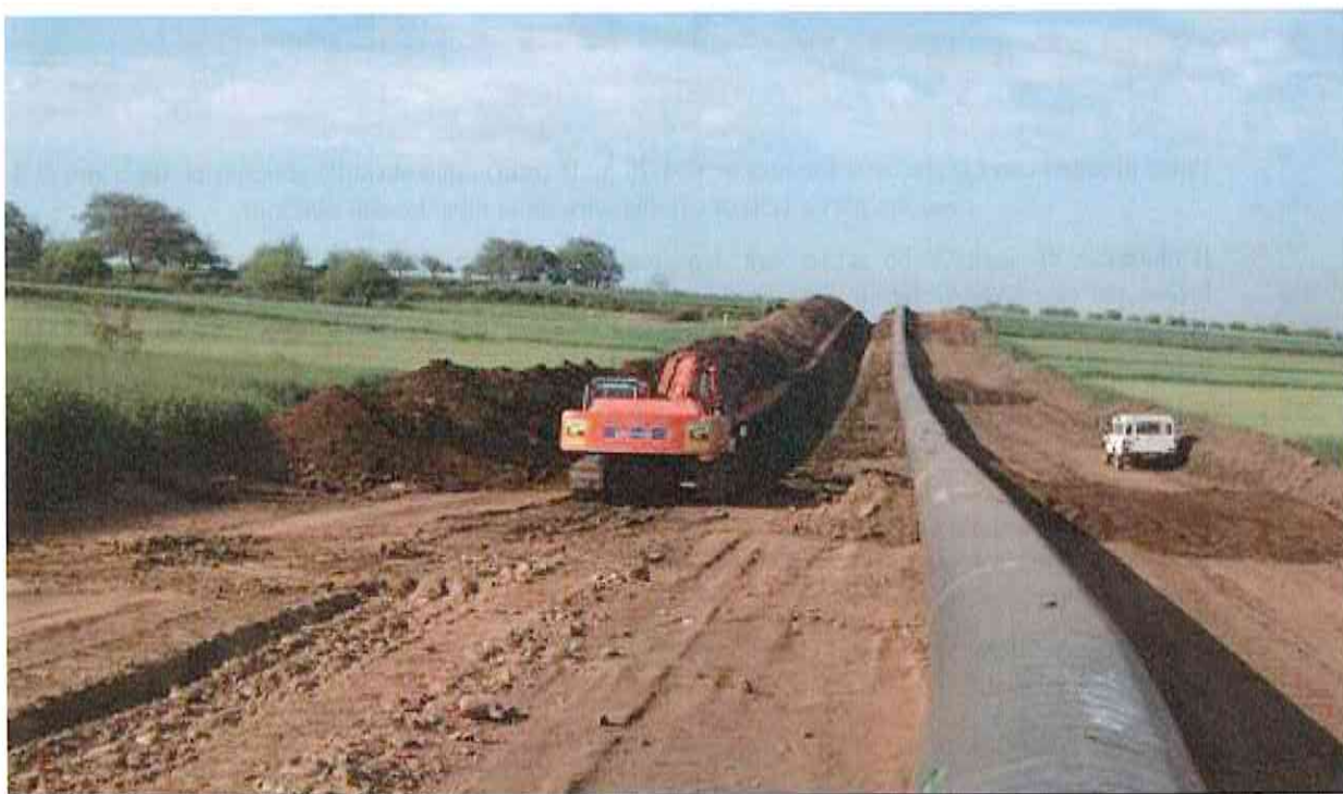
Foto tipica di scavo della trincea
