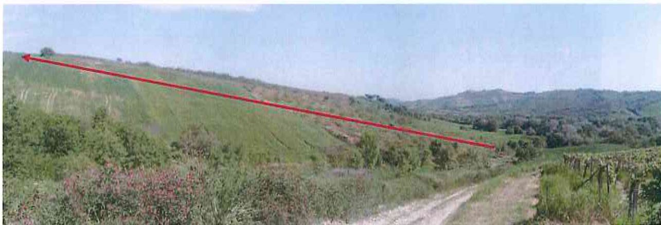
Foto 1 – Risalita versante dissestato in sinistra idrografica Fiume Osento
