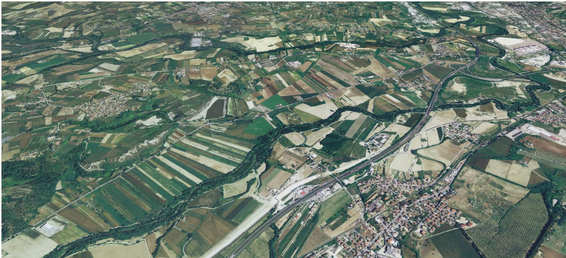
Vista d'insieme nello stato di fatto.
