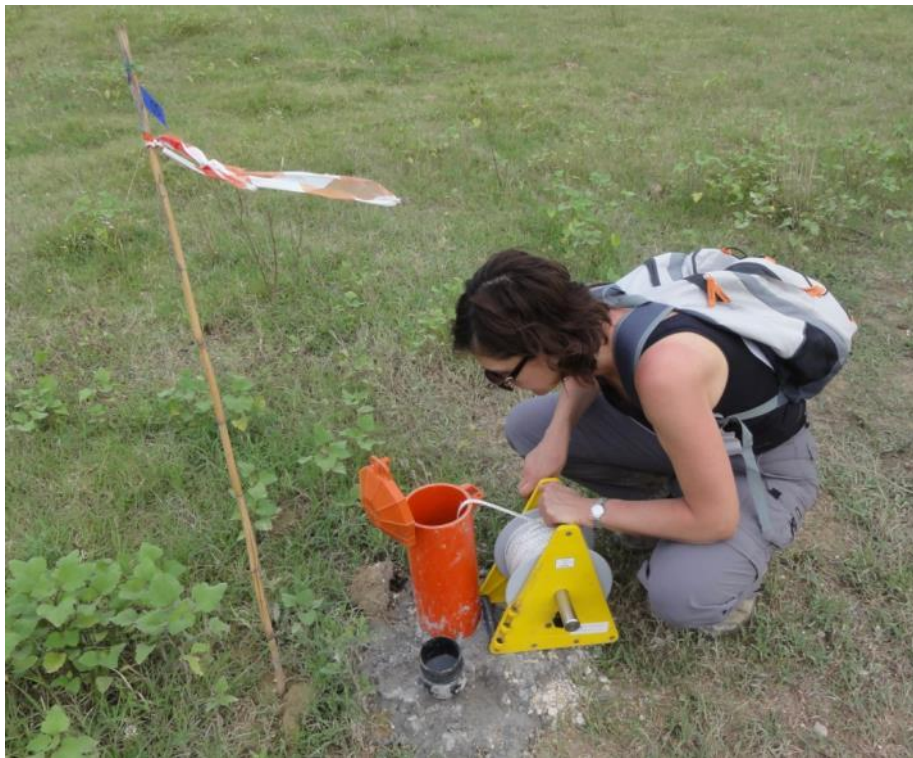
Figura 3.3 – Allestimento finale dei piezometri: tappo filettato e chiusino dotato di lucchetto.
