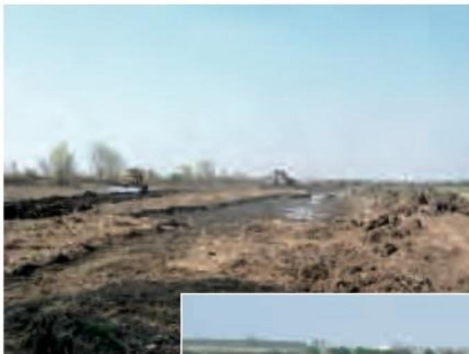
Movimenti terra per creazione prato umido. (Foto D. Cuizzi)
