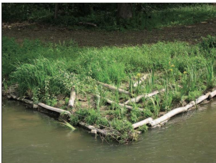
Particolari costruttivi del deflettore spondale (Fonte immagine: Vitali, 2011)
