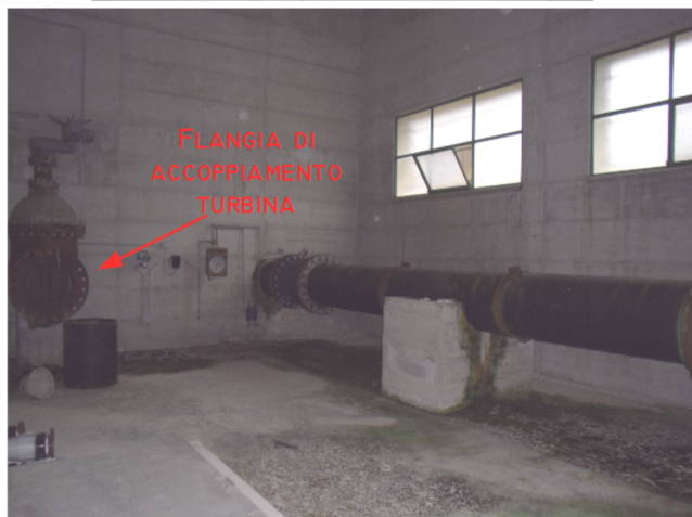
ILLUSTRAZIONE 1.4. INTERNO EDIFICIO DI CENTRALE: PARTICOLARE TUBAZIONE E FLANGIA DI ACCOPPIAMENTO TURBINA DN 600, VALVOLE DI DISSIPAZIONE DEL CARICO
