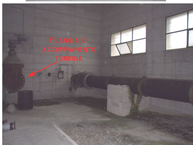
ILLUSTRAZIONE A.5. INTERNO EDIFICIO DI CENTRALE: PARTICOLARE TUBAZIONE E FLANGIA DI ACCOPPIAMENTO TURBINA DN 600, VALVOLE DI DISSIPAZIONE DEL CARICO
