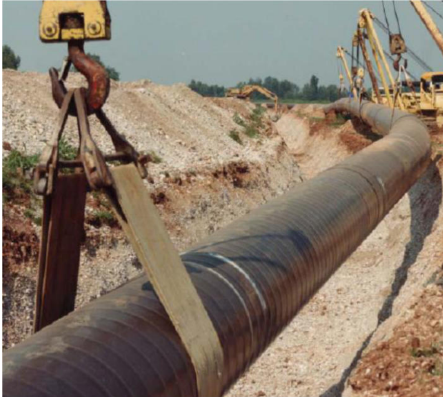
Figura 3.e: Posa tubazione
