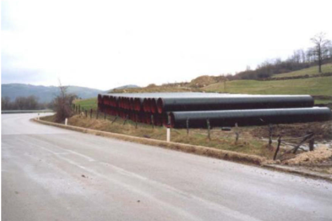
Figura 3.b: Piazzole di stoccaggio tubazioni
