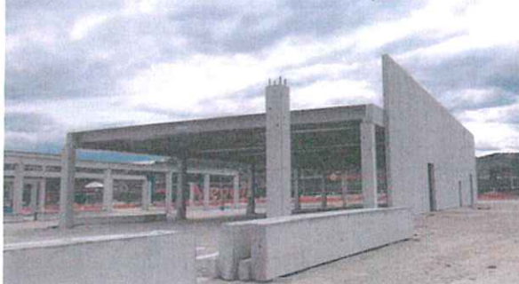
Foto 5 – Edificio Blocco 01: Strutture in elevazione da completare
