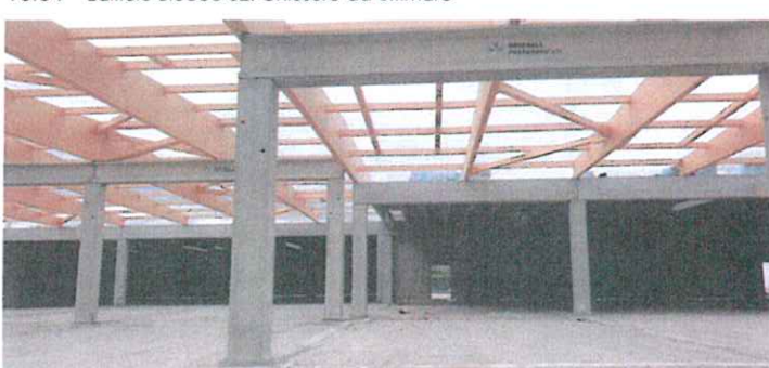
Foto 9 – Edificio Blocco 02: Chiusure da ultimare
