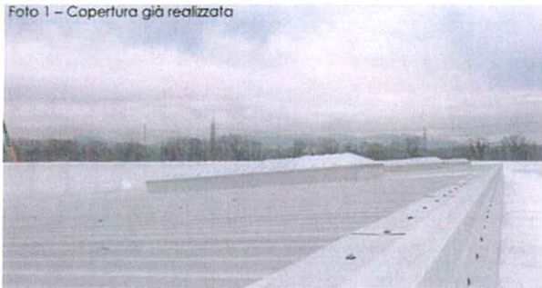
Foto 1 – Copertura già realizzata
