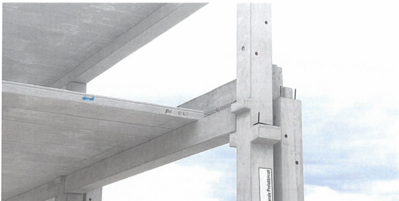
Foto 8 – Edificio Blocco 01: Particolare ancoraggi sismici da completare
