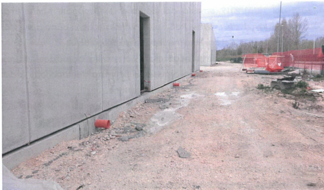
Foto 2 – Area Carico – Scarico: Tubature Pluviali ancora da collegare al collettore generale
