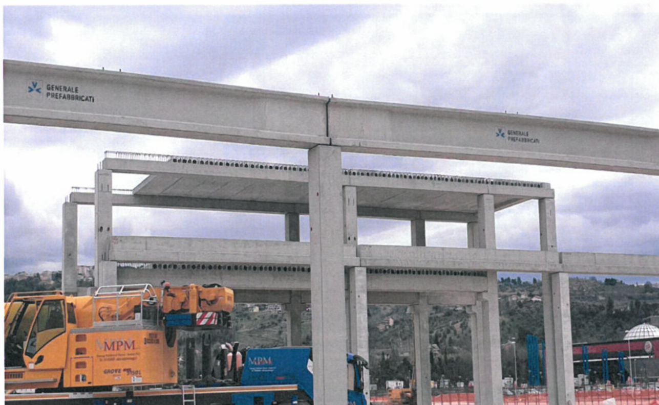
Foto 6 – Edificio Blocco 01: Strutture in elevazione da completare
