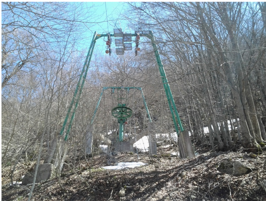
Figura 28. Particolare del 5°portale esistente e della stazione di monte.
