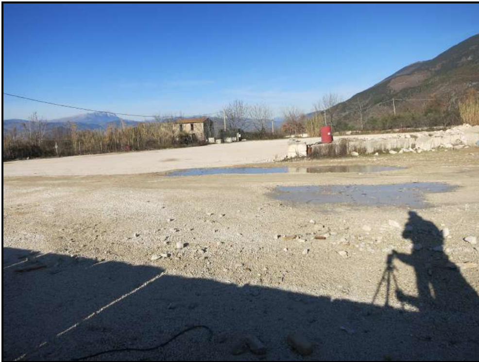
Figura 5 - Stato di fatto, area di messa in riserva
