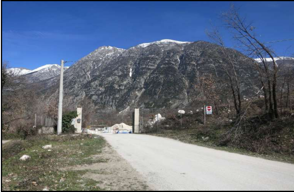
Figura 4 - Stato di fatto, ingresso principale
