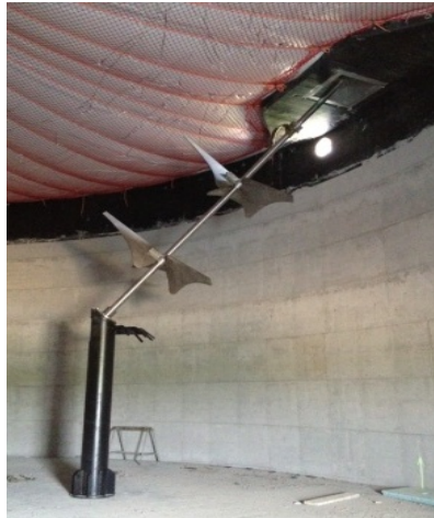
Fig. 5 - Agitatore inclinato
