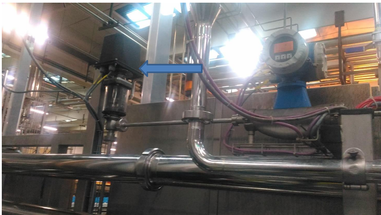
Fig. 4 Valvola modulante di regolazione della quantità di CO2.
