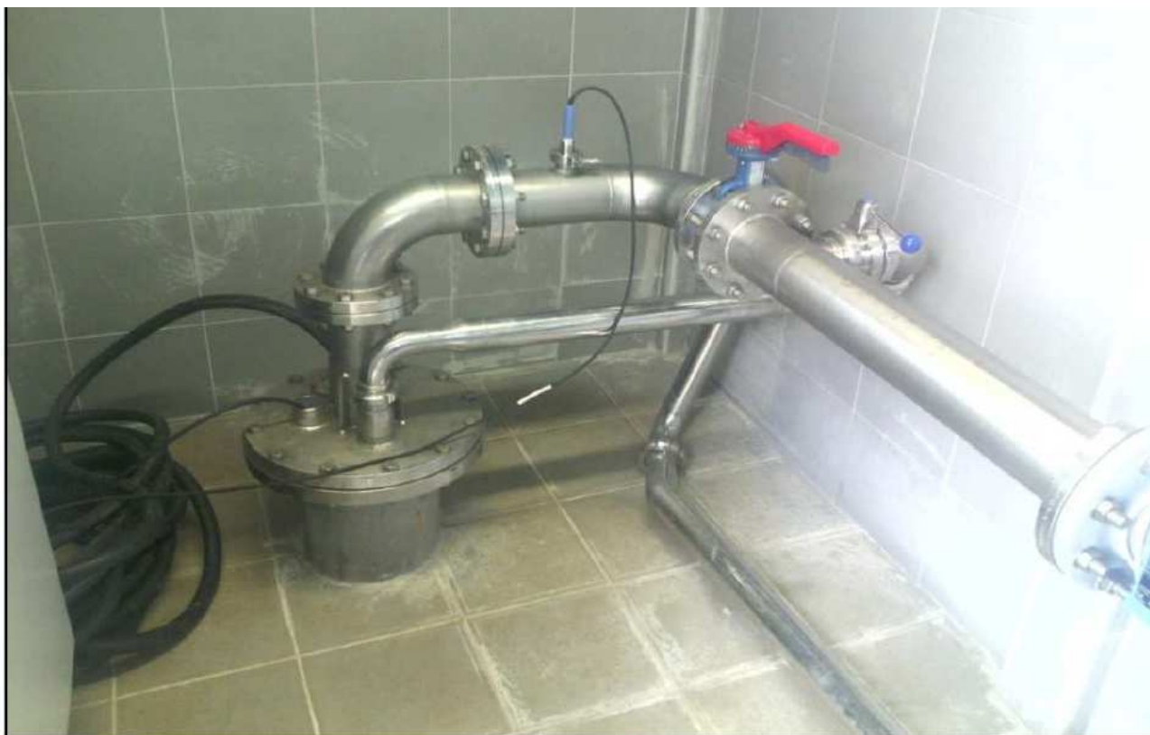
Fig. 10 Pozzo Acqua MAJA, particolare dell'interno del manufatto e della testa pozzo
