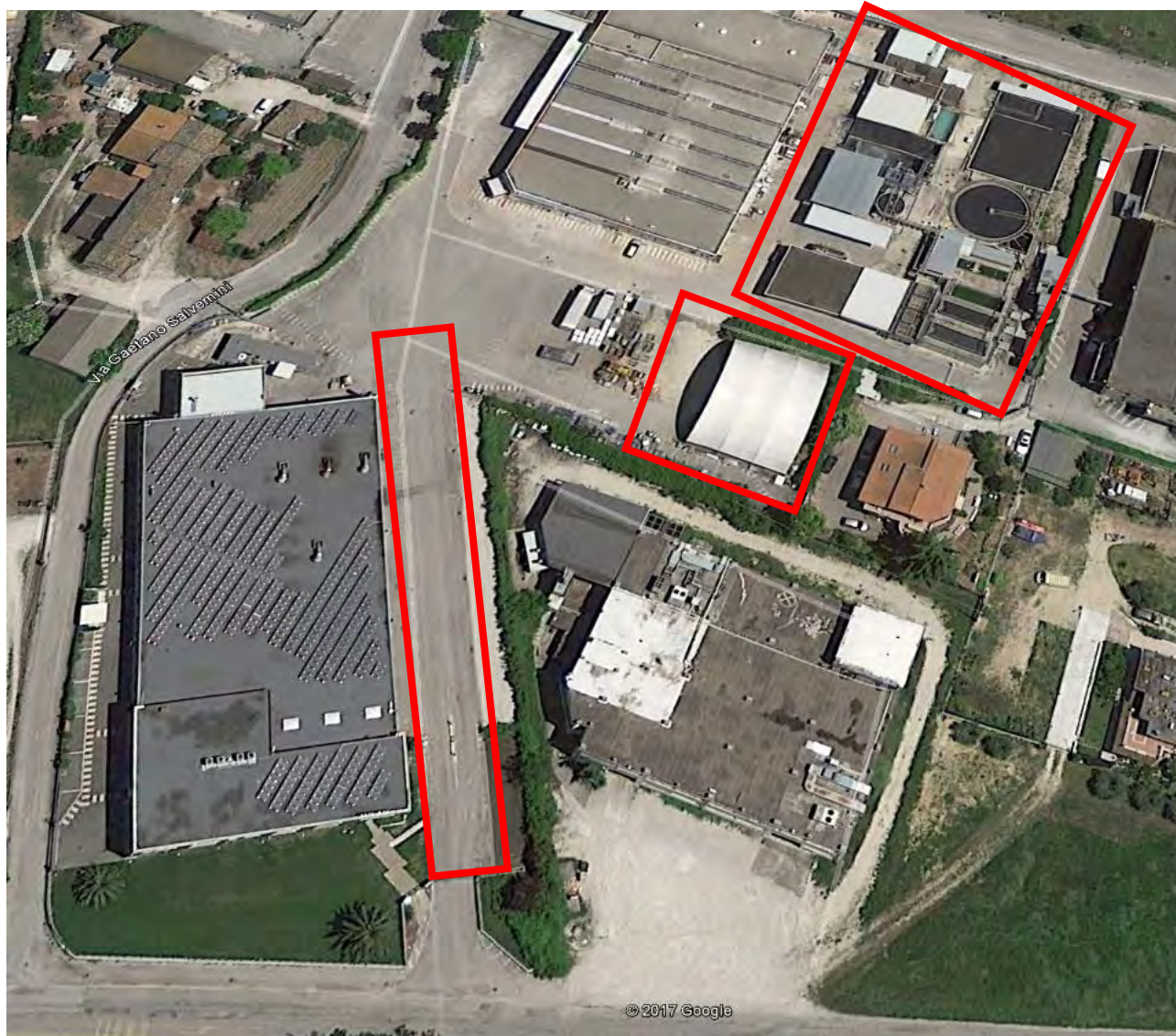
Figura 8 Orotofoto dell'area allo stato di fatto con indicazione delle aree interessate dagli interventi.
