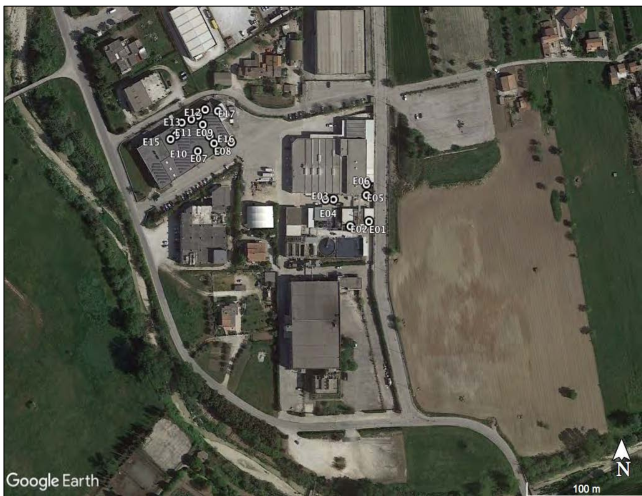
Figura 9: Dettaglio dei punti di rilascio delle emissioni convogliate nell'azienda oggetto di studio.
