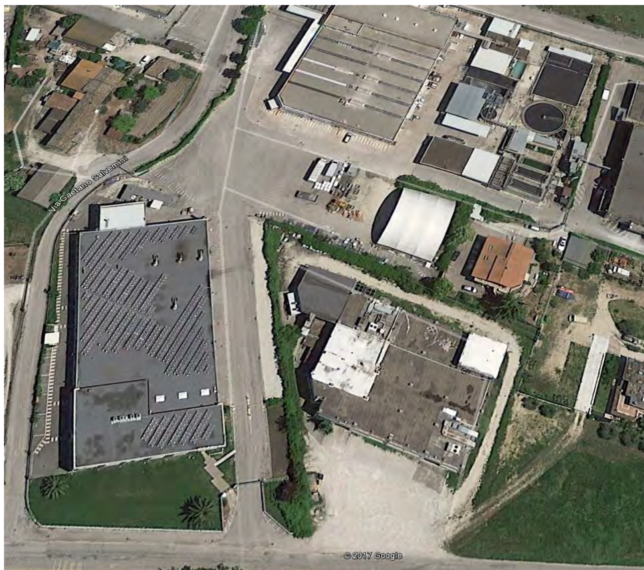
Figura 7 Ortofoto dell'area allo stato di fatto
