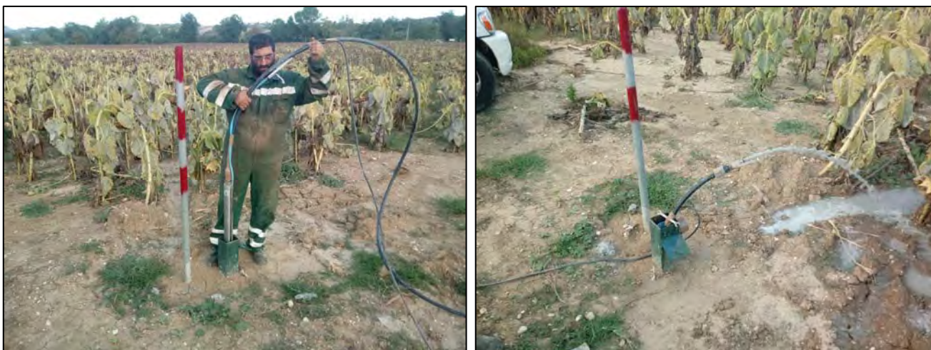
Fig.3: Fasi dello spurgo dei piezometri.
