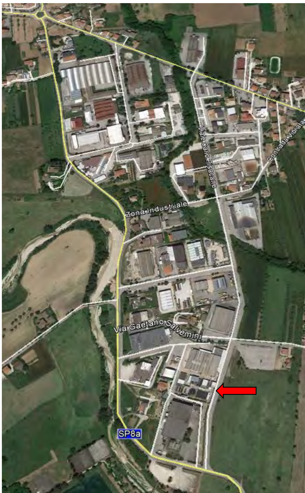
Figura 1 Vista dall'alto del sito di interesse e della zona limitrofa industriale
