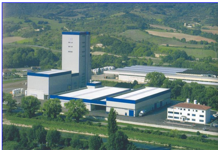
Stabilimento FASSABORTOLO realizzato nella zona industriale di Popoli (PE)
