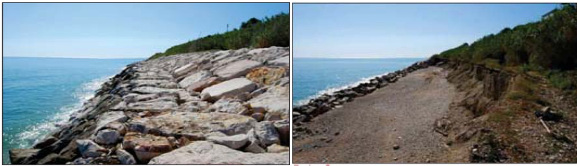
Foto 1 – Difesa radente; Foto 2 – Zona oggetto dello smottamento.
