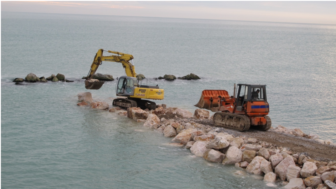
Realizzazione di pennello da terra con escavatore e pala meccanica
