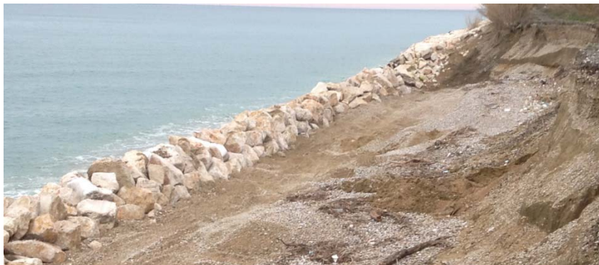
Foto della scogliera radente posta in opera dalla Regione Abruzzo nel mese di gennaio 2014.
