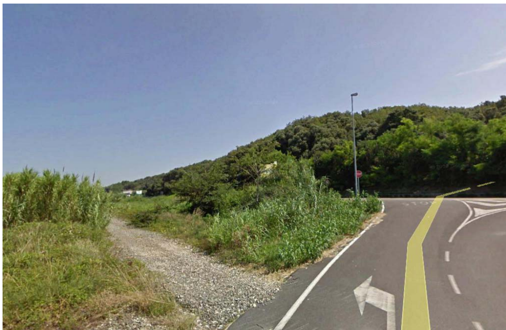
Foto 2 – Ingresso su tracciato ex ferrovia
