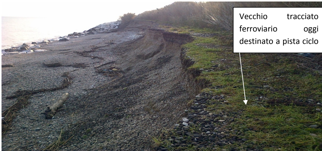
Vista da NW verso SE del tratto di costa interessato dalla frana.
