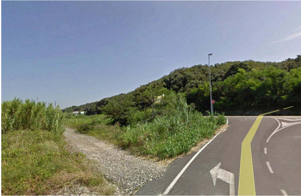
Foto 2 – Ingresso su tracciato ex ferrovia
