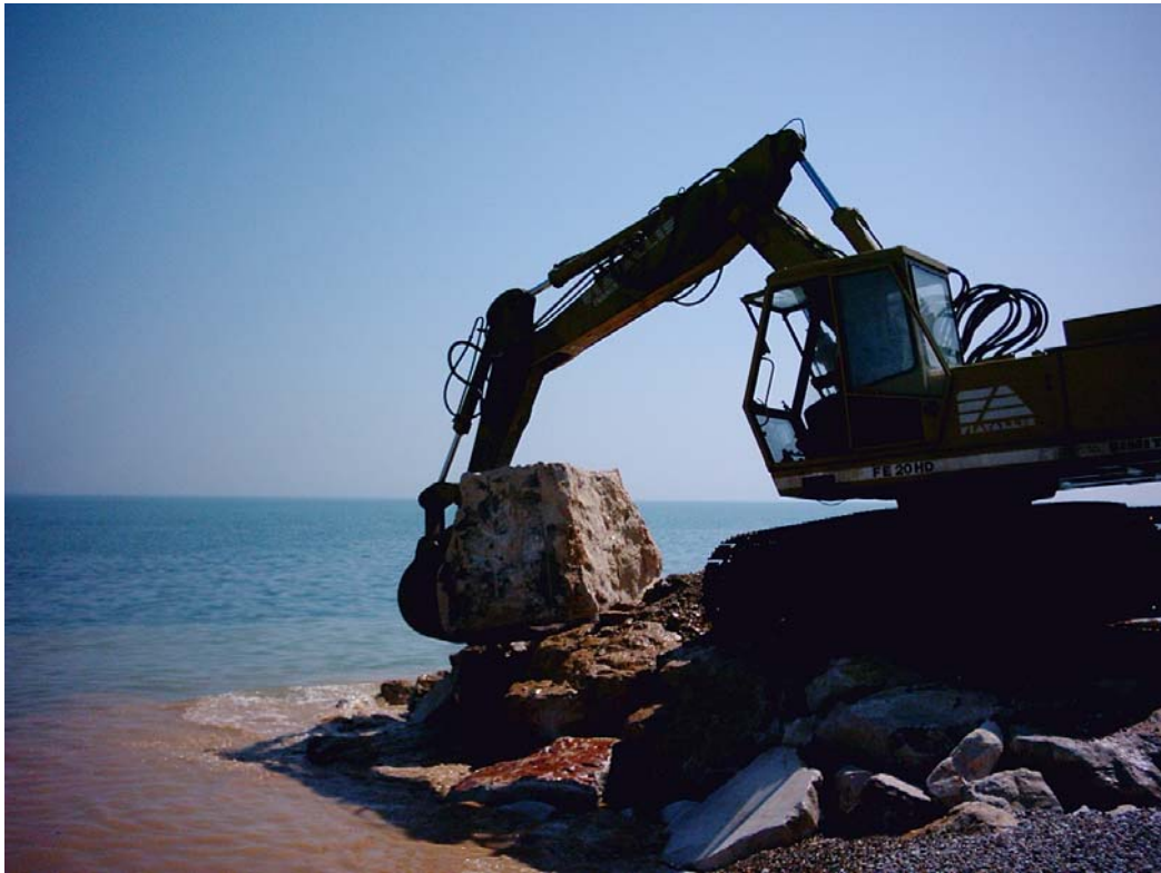
Escavatore meccanico cingolato intento a movimentare gli scogli
