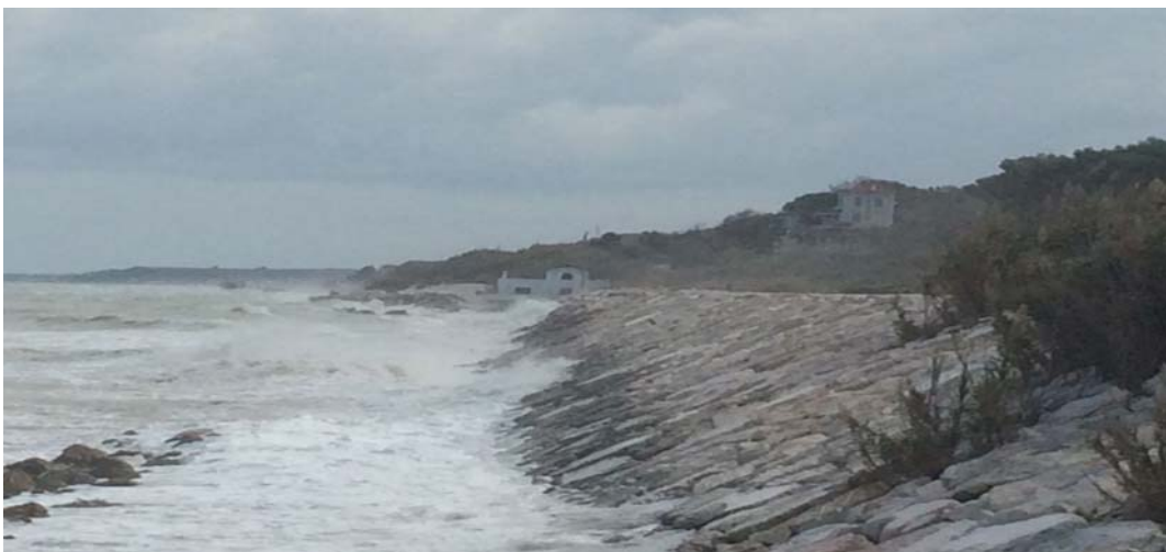
Area di intervento (sullo sfondo dove è la casa) durante una mareggiata della primavera 2016
