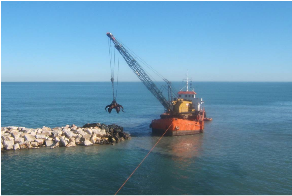
Motopontone all'opera con gru a grappo per la movimentazione e posa in opera dei massi.
