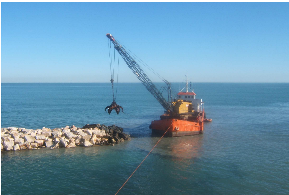
Motopontone all'opera con gru a grappo per la movimentazione e posa in opera dei massi.
