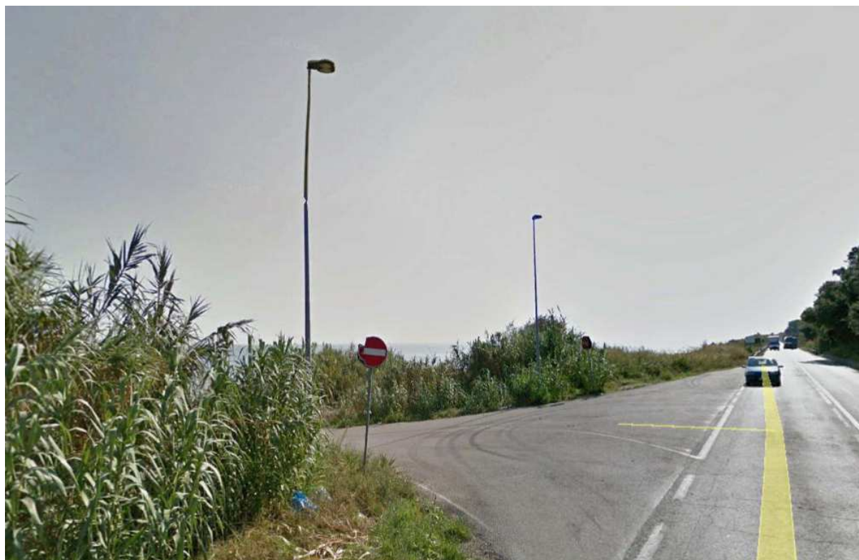
Inizio percorso di accesso al cantiere – Km 493+300 della S.S. 16
