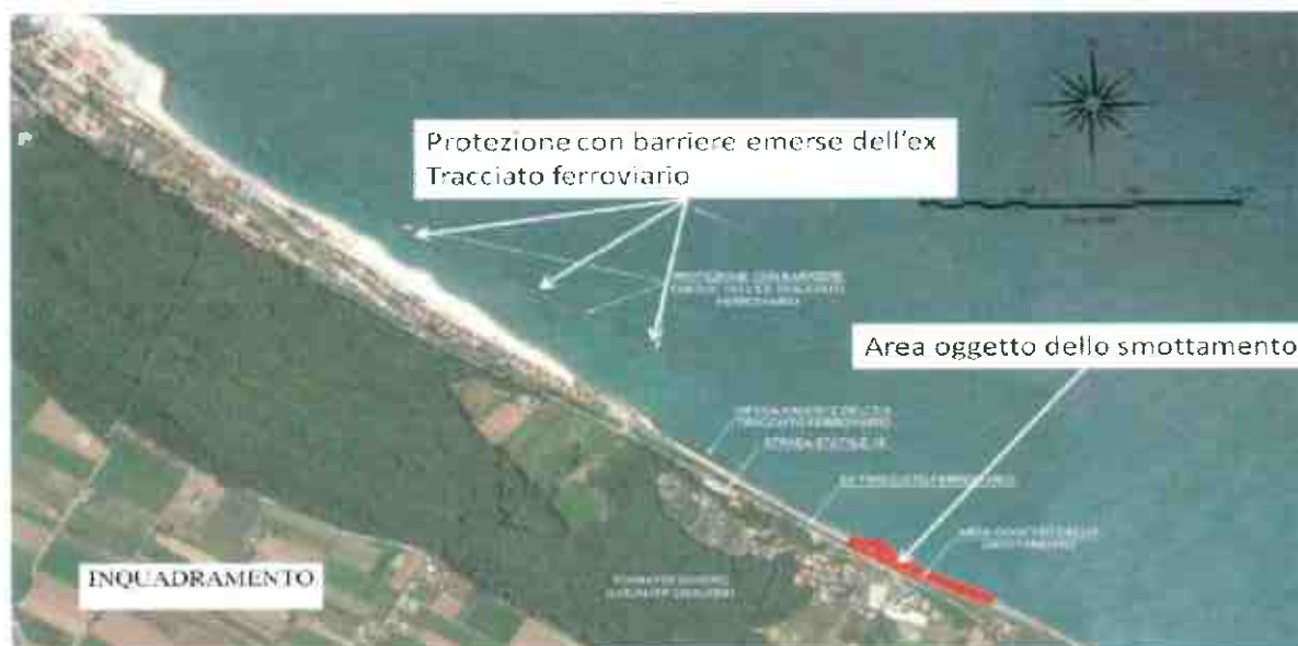
Fig. 1 Inquadramento del tratto di costa oggetto dello smottamento (in rosso)
