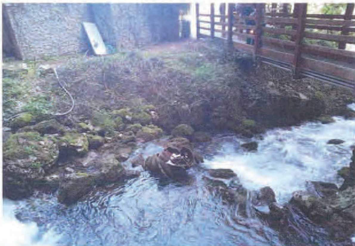
Fig.8-San Demetrio né Vestini -fraz. Stiffe –Part. Dell'invaso sotto l'ingresso della grotta con residui della centrale novecentesca
