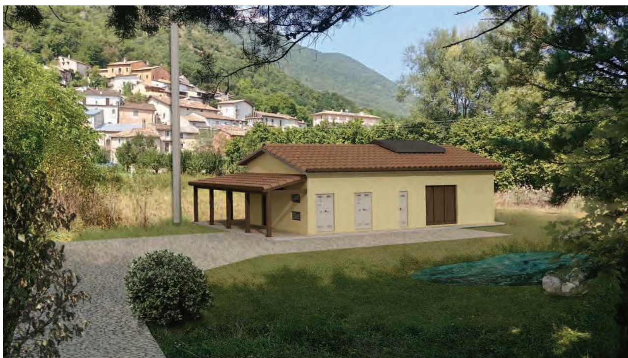
Edificio di centrale – Post operam
