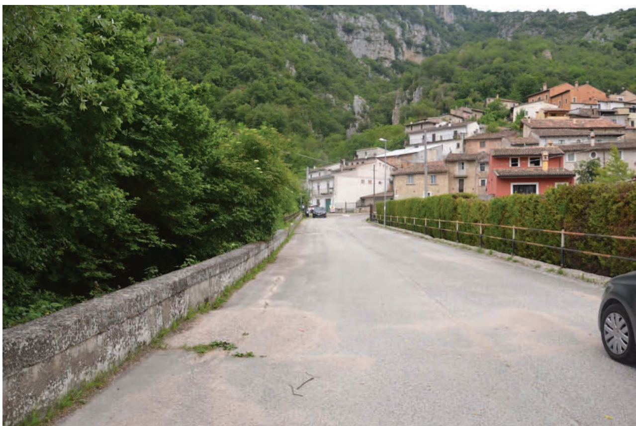
Tratto di strada di ingresso all'abitato di Stiffe, confinante con l'area di sedime del fabbricato di centrale
