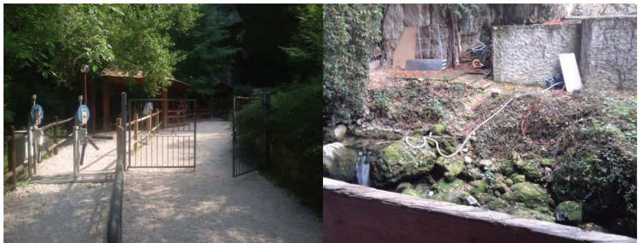
Ingresso alla zona di ingresso alle grotte di Stiffe e vista del sito dove verrà realizzata l'opera di presa
