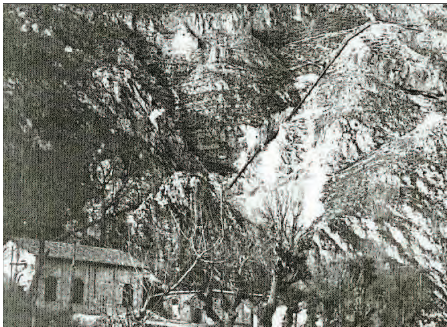
Figura 4. Tratto terminale della condotta forzata e l'edificio della centrale
