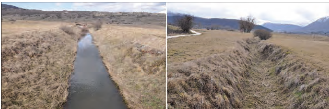
Figura 17. Il canale D – E
