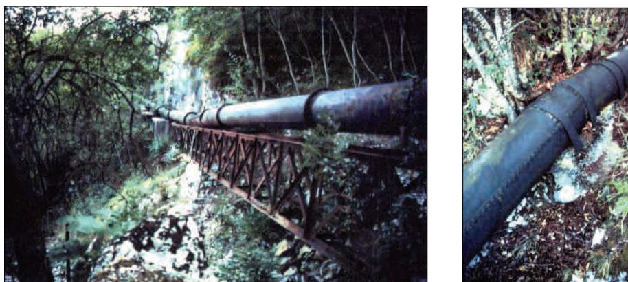
Figura 5. Resti ancora visibili della condotta forzata
