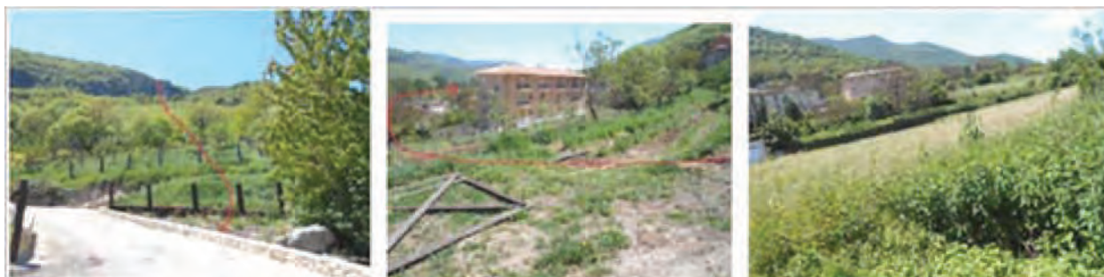
Attraversamento dei coltivi (meleti) e orti. La linea rossa indica il percorso della condotta
