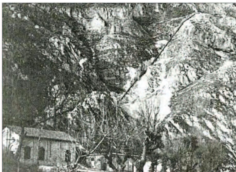
Fig. I.6 – Tratto terminale della condotta forzata e l'edificio della centrale
