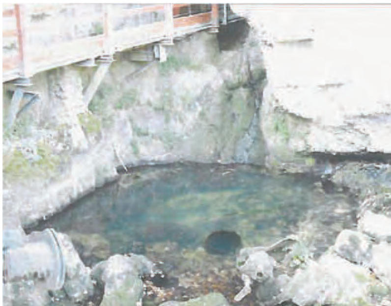
Foto I.3 - I resti della condotta e di alcuni organi di regolazione presso il laghetto all'imboccatura della grotta
