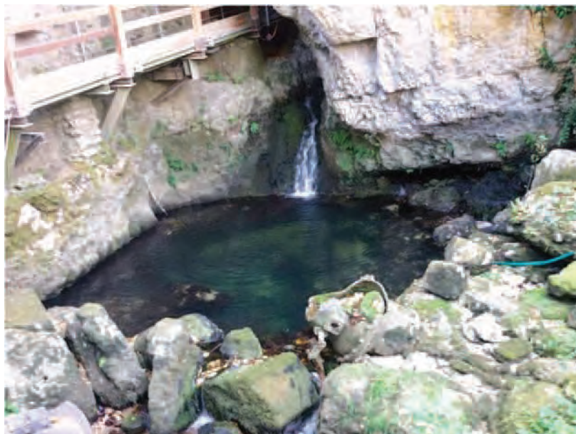
Ubicazione dell'opera di presa e passerella di accesso alle grotte
