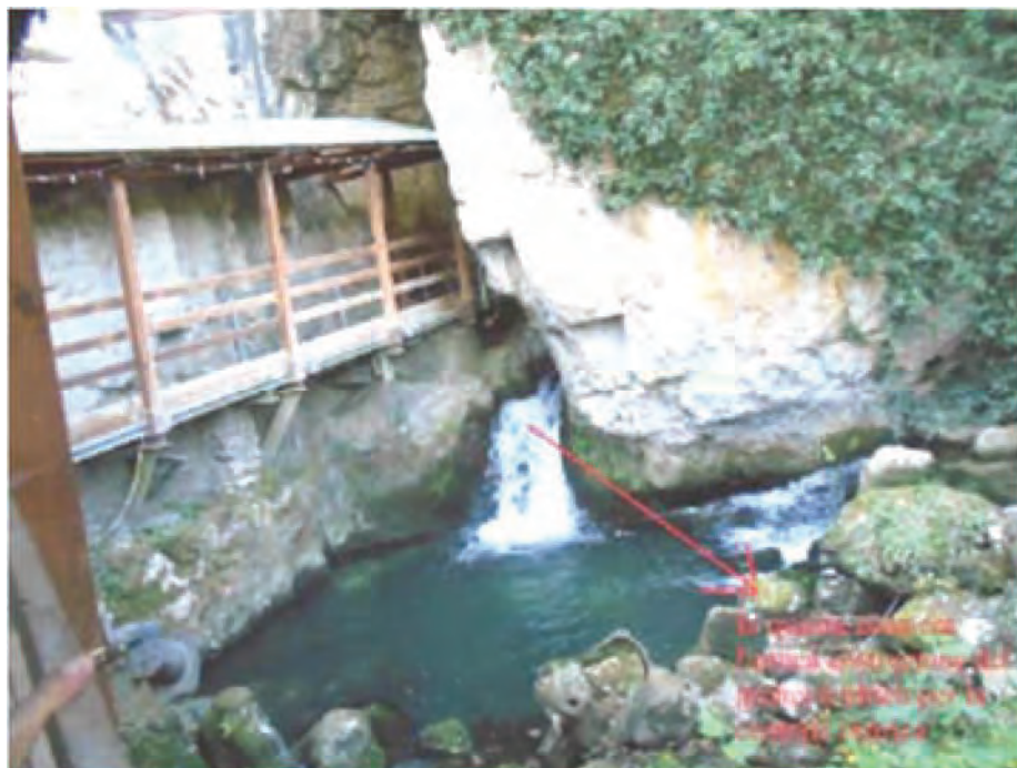
Resti dell'antica captazione dell'acqua per la condotta.
