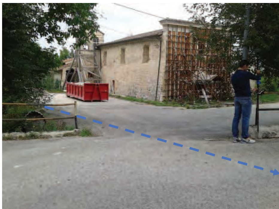
Vista su tratto di tracciato della condotta interrata in uscita dal piazzale della chiesa di S. Andrea e nell'attraversamento della strada
