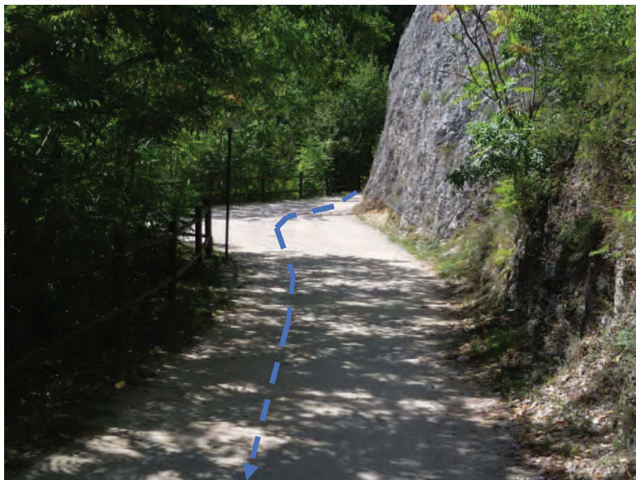
Tratto iniziale della strada bianca che dalle grotte conduce all'abitato di Stiffe e dove verrà interrata la condotta DN800 che dalla presa arriverà in centrale
