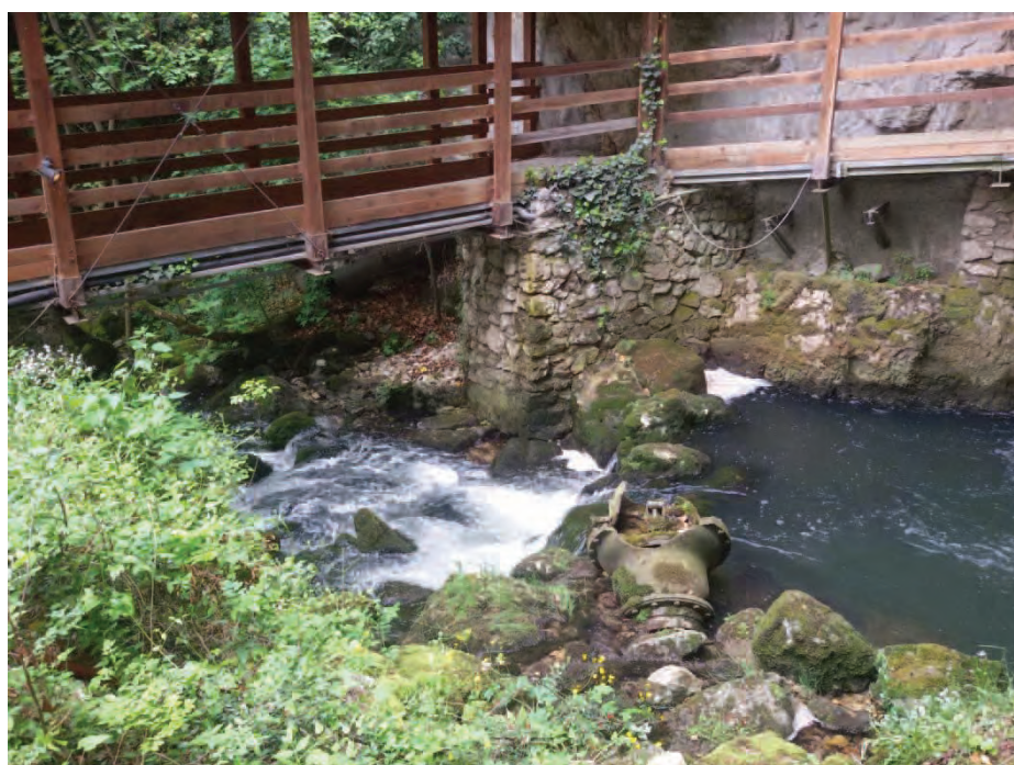
Piccola briglia in pietra esistente nella zona della fuoriuscita dell'acqua dalle grotte, nello stesso punto verrà realizzata la nuova briglia per l'opera di presa
