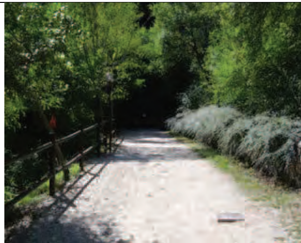
Fig. 3c: tratto di posa della condotta forzata
