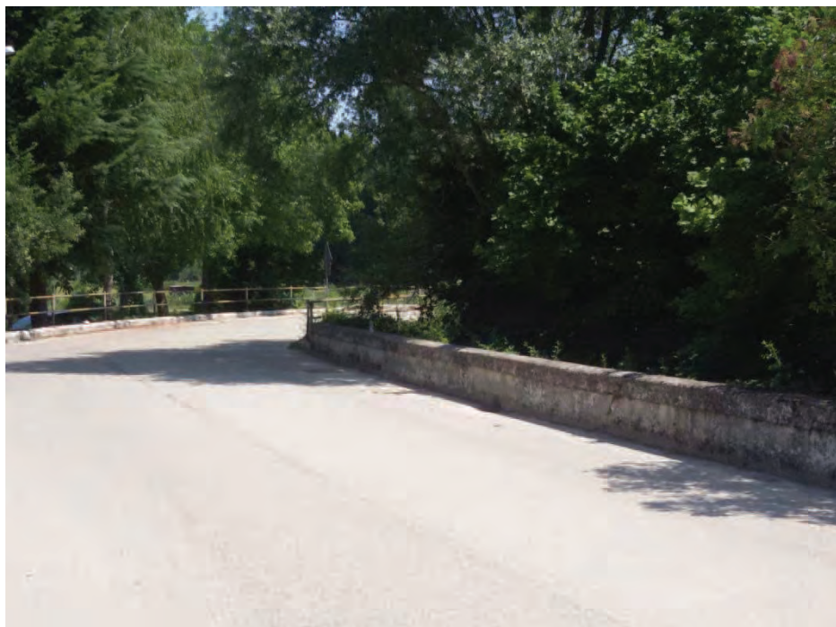
Tratto della strada di ingresso all'abitato di Stiffe confinante in dx con il torrente Rio La Foce e con l'area di sedime del fabbricato Centrale
