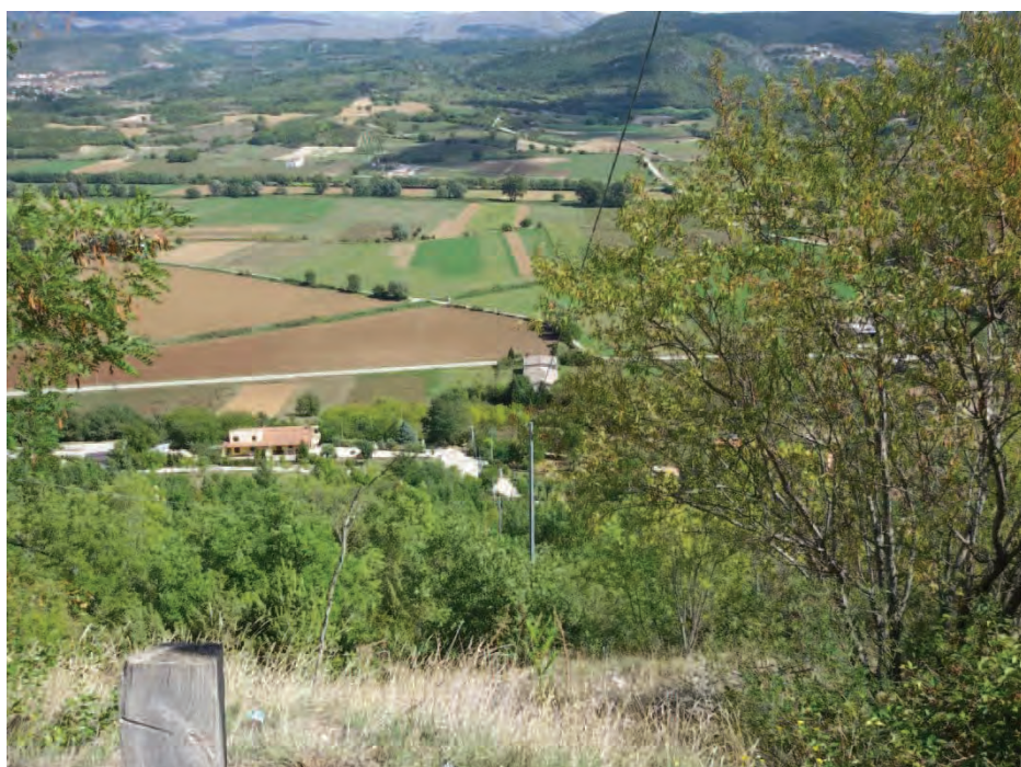
Vista dall'alto del tragitto della condotta interrata su terreni agricoli
