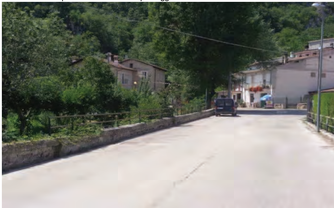
Fig. 3g: tratto di posa condotta forzata nei pressi dell'attraversamento del Rio La Foce
