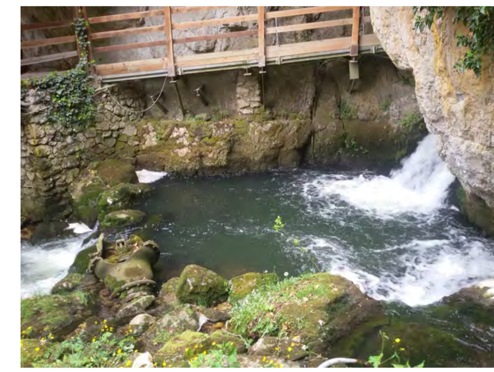
Foto 4 - Vista bacino di scarico acqua proveniente dalle grotte e posizione dell'opera di presa in progetto
