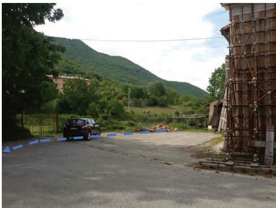
Vista su tratto di tracciato della condotta interrata sul piazzale della chiesa di S. Andrea
