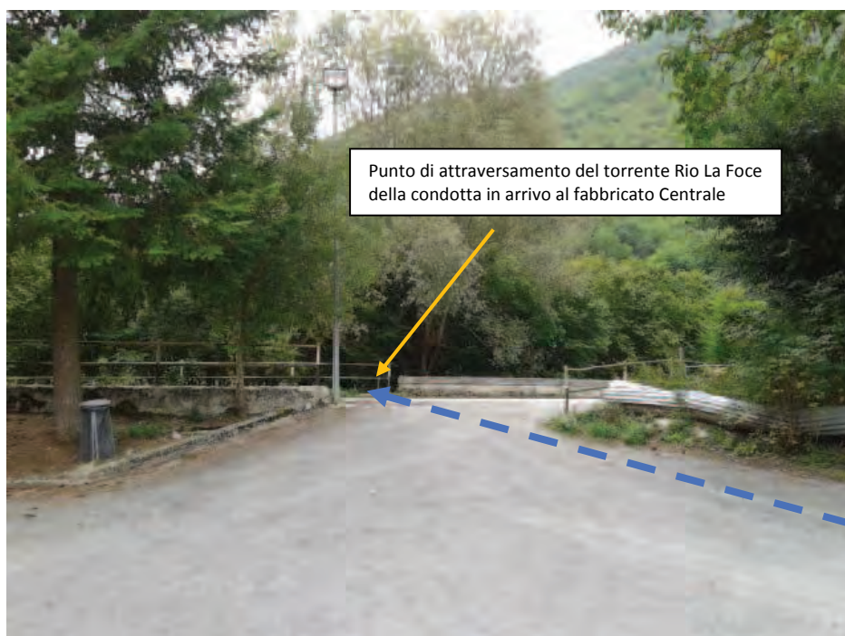
Vista su tratto di tracciato della condotta interrata in uscita dal piazzale della chiesa di S. Andrea
