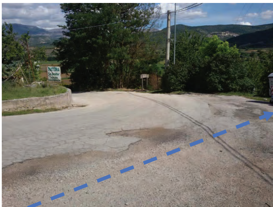
Tratto di condotta con percorso tangente ad una curva della strada asfaltata
