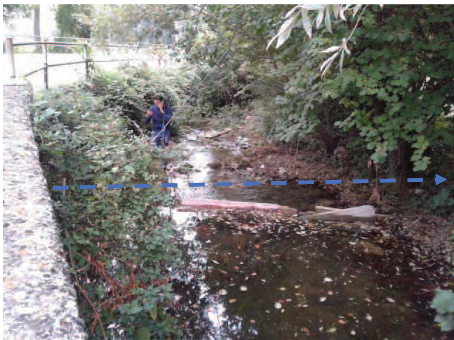
Vista su tratto del torrente Rio La Foce che sarà attraversato in sotterraneo dalla condotta forzata in prossimità dell'arrivo sull'area di sedime del fabbricato Centrale
