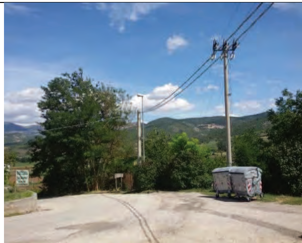
Fig. 3f: tratto di posa condotta forzata nei pressi del Ristorante le Grotte
