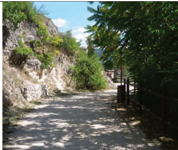
Fig. 3d: tratto di posa della condotta forzata
