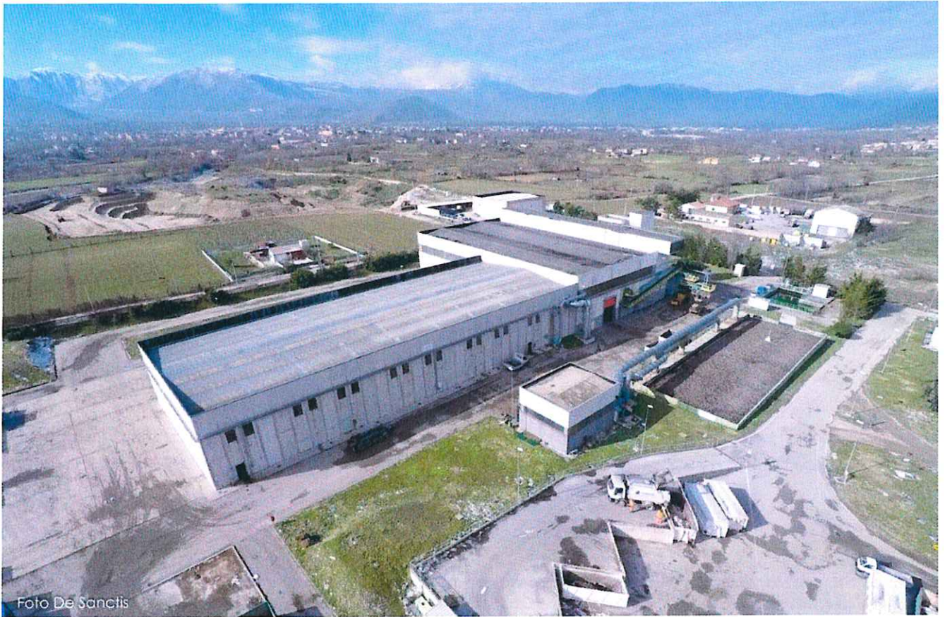
Stato attuale dell'impianto all'impianto in Loc. Noce Mattei in Sulmona”
