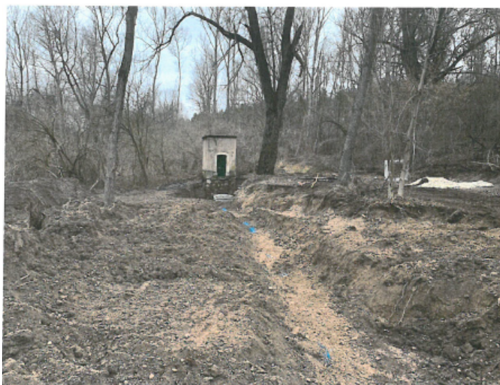
Figura 10 Evidenza dei lavori di riattivazione della condotta di acqua potabile nel centrale di San Pio delle Camere e nella Frazione di Castelnuovo
