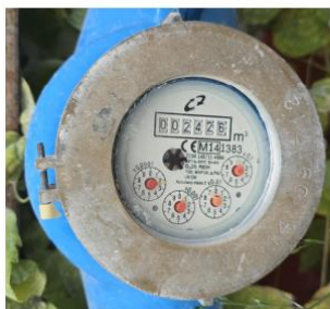
Foto 2 - Contatore già installato
