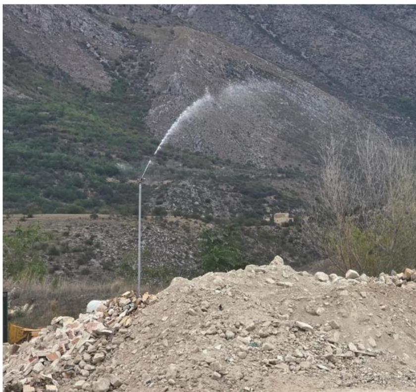
Foto 7 - Rete ugelli nebulizzatori per abbattimento polverosità –Cumuli area di messa in riserva
