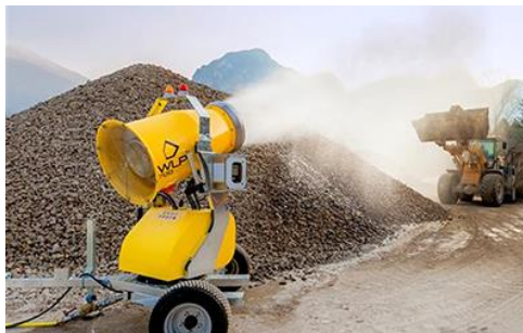
Esempio di Irrorazione delle aree di cantiere.
