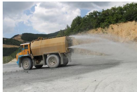
Esempio di Irrorazione delle aree di cantiere.
