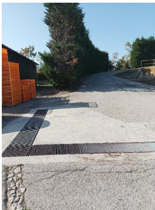
Figura 8: Griglia raccolta acque meteoriche provenienti dalla strada ingresso e canale sgrondo
