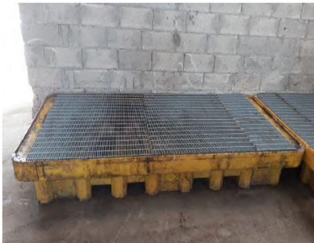
RIRPISTINO BACINI DI CONTENIMENTO
