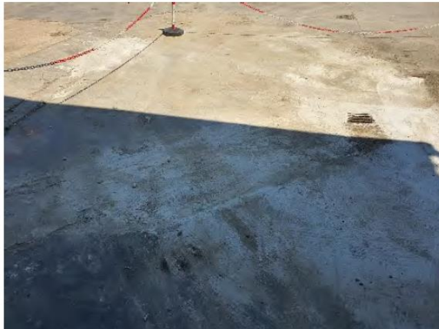
RIPRISTINO FESSURAZIONI SUPERFICIALI
