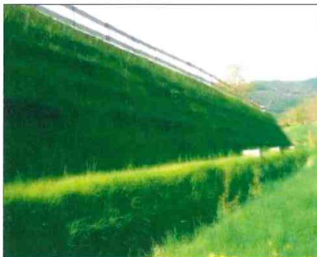
Fig. 32 – A sinistra, Esempio di viminata viva | A destra, Esempio di terra rinforzata (da “Relazione QR Progettuale” allegata allo SIA)
