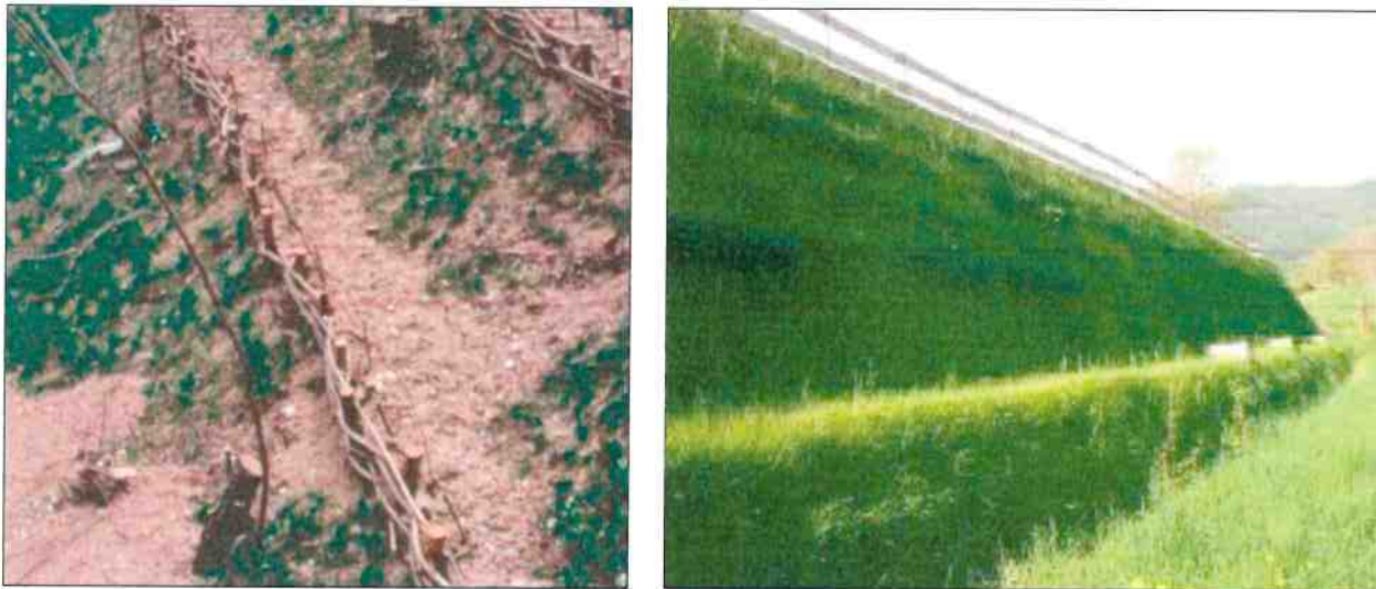
Fig. 32 – A sinistra, Esempio di viminata viva | A destra, Esempio di terra rinforzata (da “Relazione QR Progettuale” allegata allo SIA)
