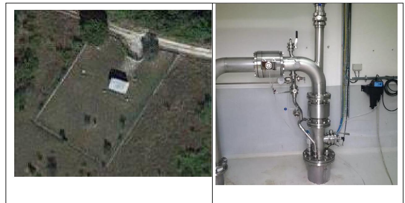
Figura 4 – A sinistra: Ubicazione del pozzo Valle Reale n. 1. A destra: testa pozzo in acciaio INOX 304L.
