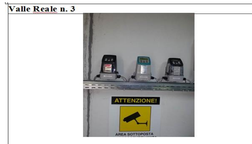
Figura 4 – Foto contatore pozzo Valle Reale n. 3
