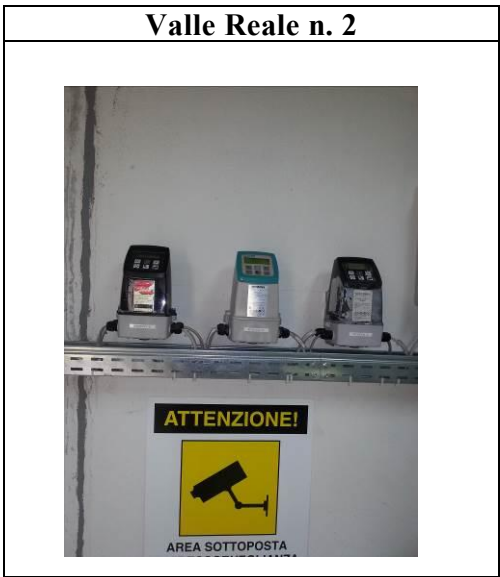
Figura 4 – Foto contatore pozzo Valle Reale n. 2 installato all'interno del casotto del pozzo n. 2
