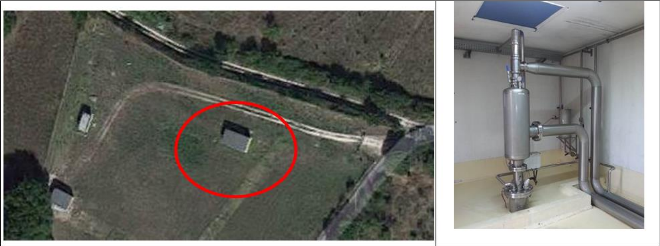
Figura 4 – A sinistra: Ubicazione del pozzo Valle Reale n. 2. A destra: testa pozzo in acciaio INOX 304L.
