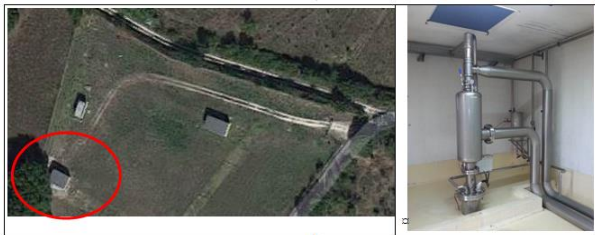
Figura 4 – A sinistra: Ubicazione del pozzo Valle Reale n. 3. A destra: testa pozzo in acciaio INOX 304L.
