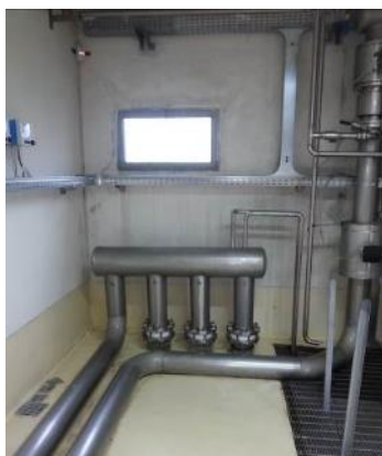
Collettore di mandata acqua di esubero dei pozzi situato all'interno del casotto pozzo n. 2
