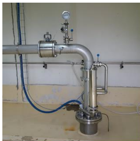
Testa pozzo in acciaio INOX 304L.
