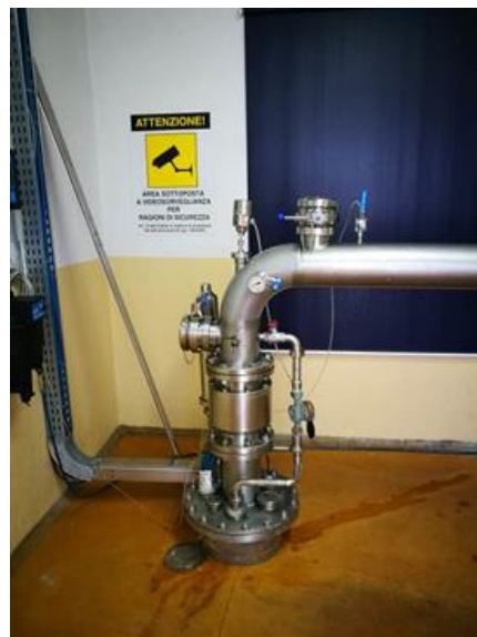
Testa pozzo in acciaio INOX 304L.
