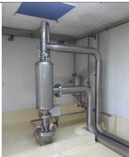
Testa pozzo in acciaio INOX 304L.
