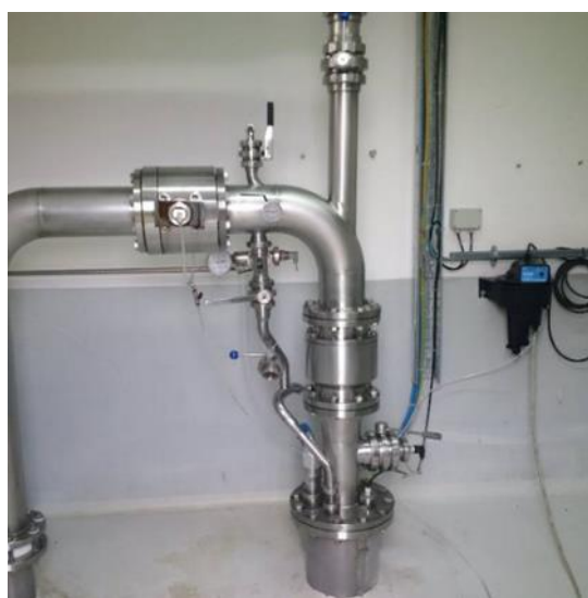
Testa pozzo in acciaio INOX 304L.
