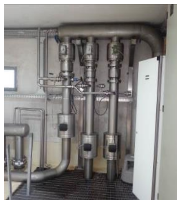
Collettore di mandata acqua minerale situato all'interno del casotto pozzo n. 2
