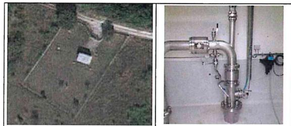
Figura 4 – A sinistra: l’ubicazione del pozzo Valle Reale n. 1. A destra: testa pozzo in acciaio INOX 304L
