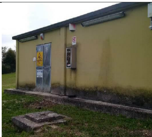
Foto edificio casotto pozzo n. 2
