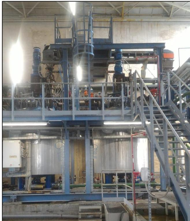
Il collegamento tra l'impianto di processo e i serbatoi di stoccaggio dell'acido cloridrico soluzione avviene mediante tubazione aerea dedicata su rack.
