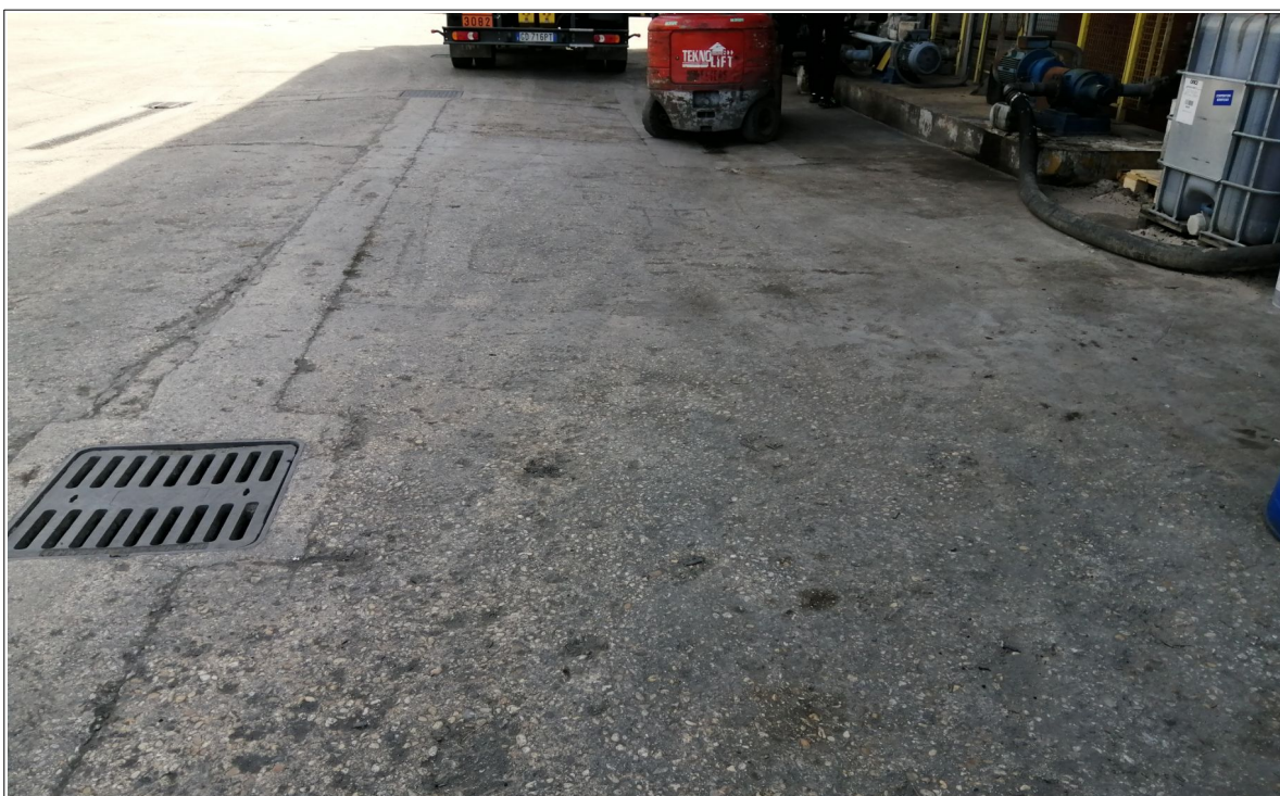
Foto 2: Stato del Piazzale zona A-Sistema raccolta acque
