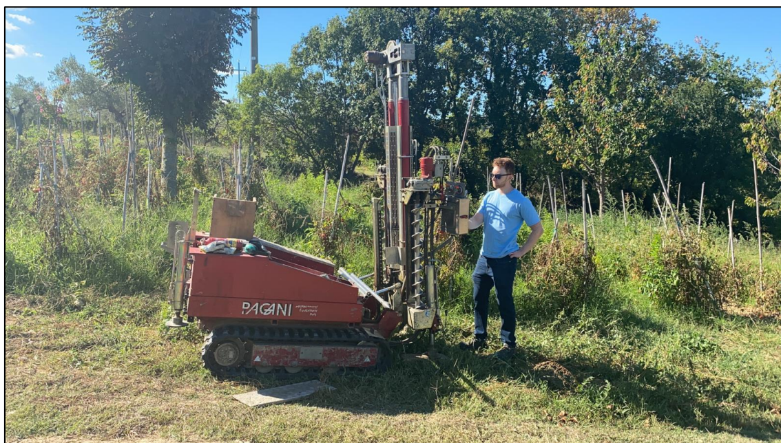
Foto postazione DPSH1
