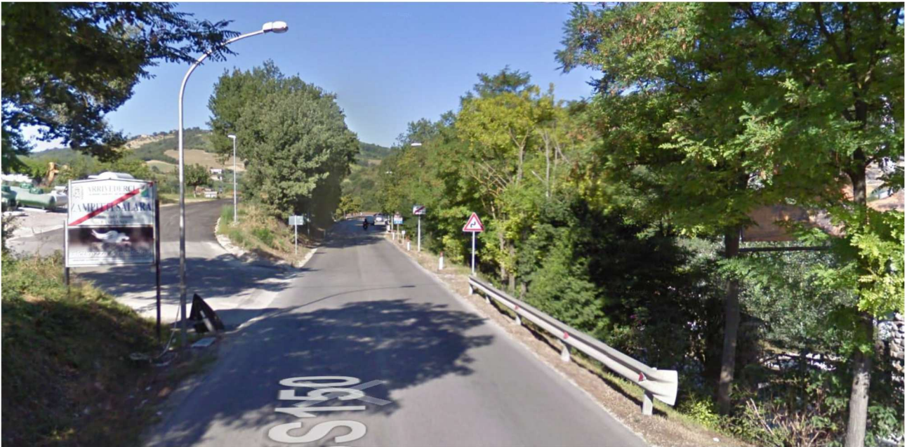
SS. 80 – strada comunale di accesso
