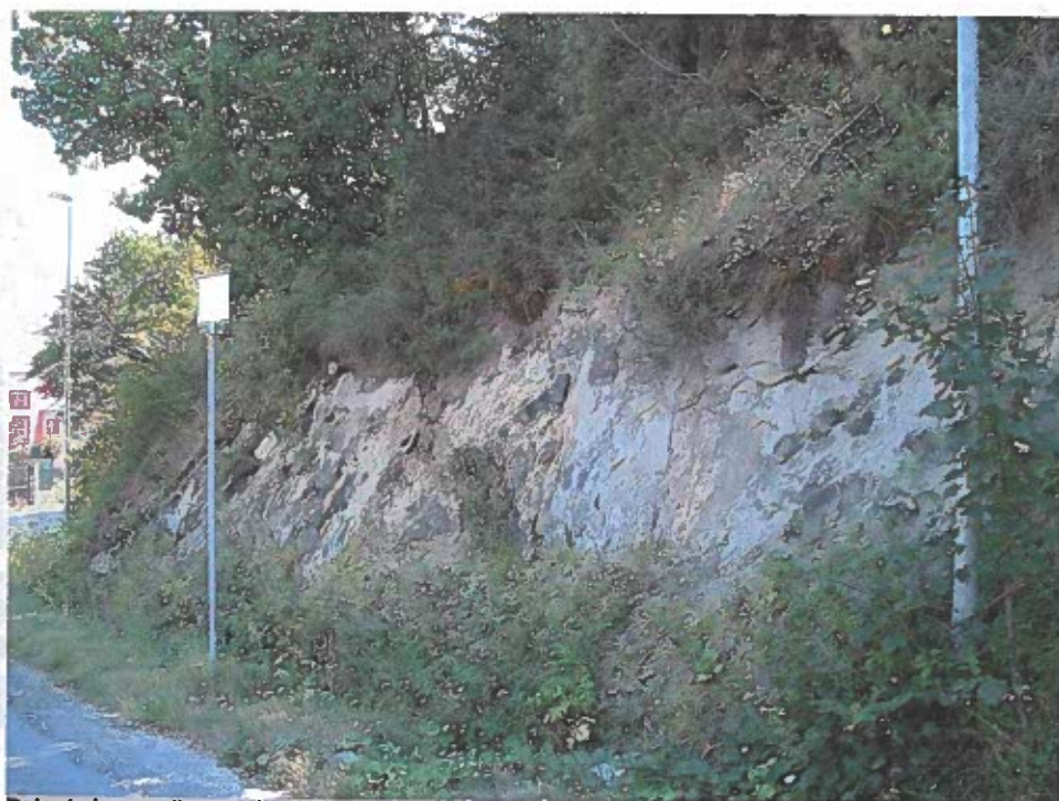
Potente banco di arenaria affiorante al bivio per Colle di Sassa, in prossimità del sito preso in esame
