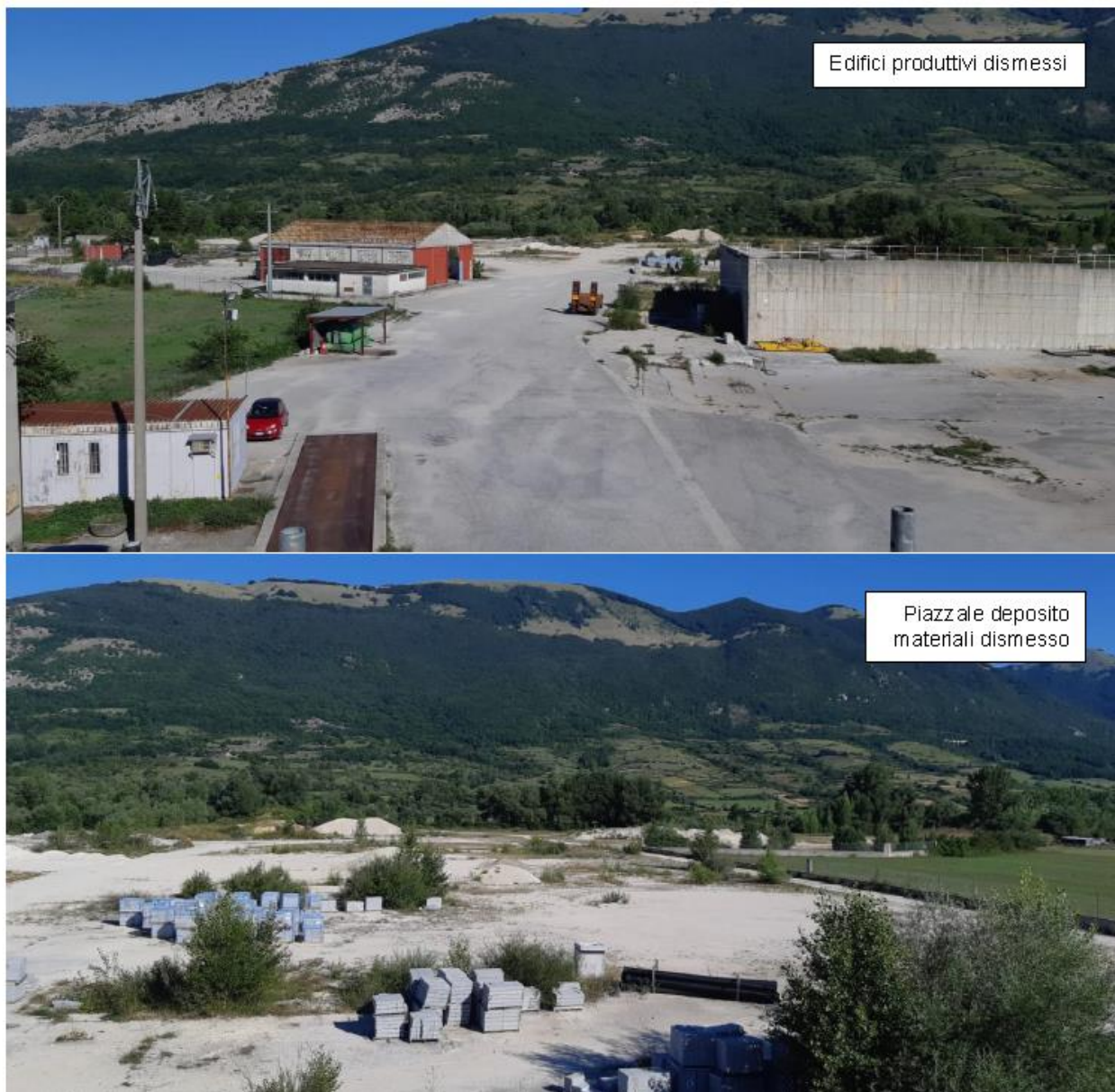
Figura 58 Documentazione fotografica inerente l'attuale stato dei luoghi.
