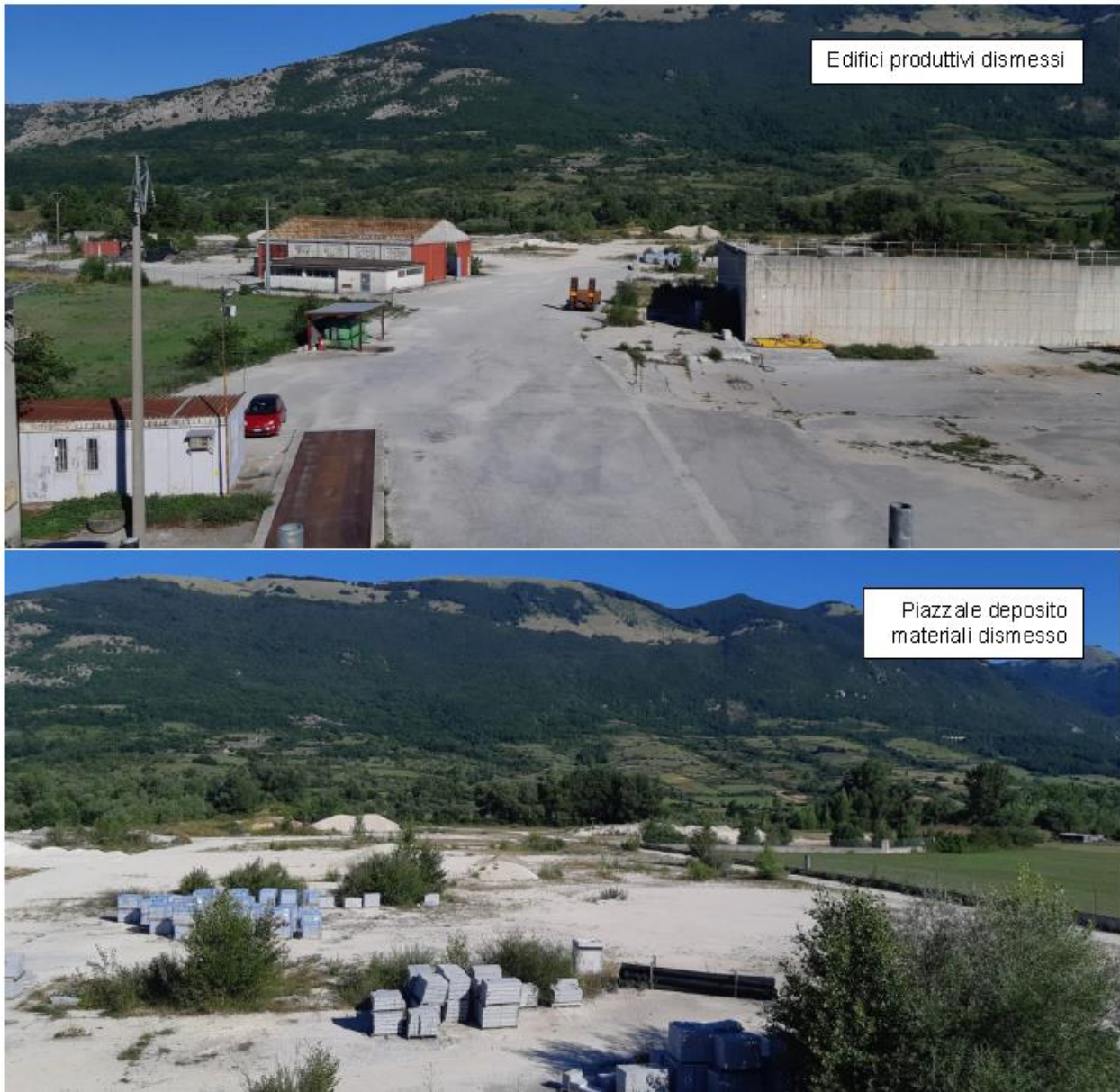
Figura 2 Documentazione fotografica inerente l'attuale stato dei luoghi. Focus 1: piazzale ed edifici produttivi dismessi.
